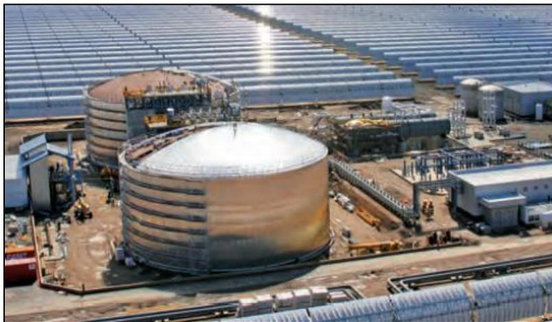
Figura 3.17: Central termosolar con almacenamiento térmico (Andasol, España).
