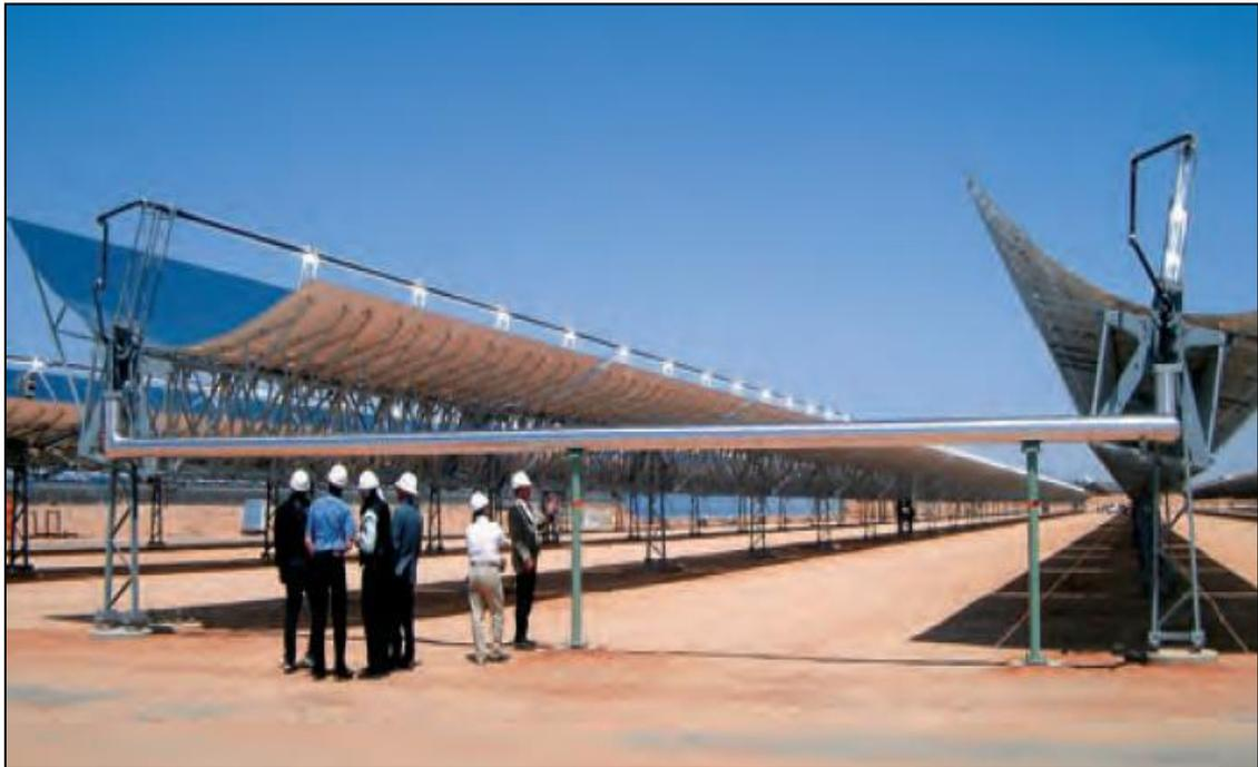
Figura 3.8: Central termosolar tipo concentradores Cilíndrico-Parabólico.
