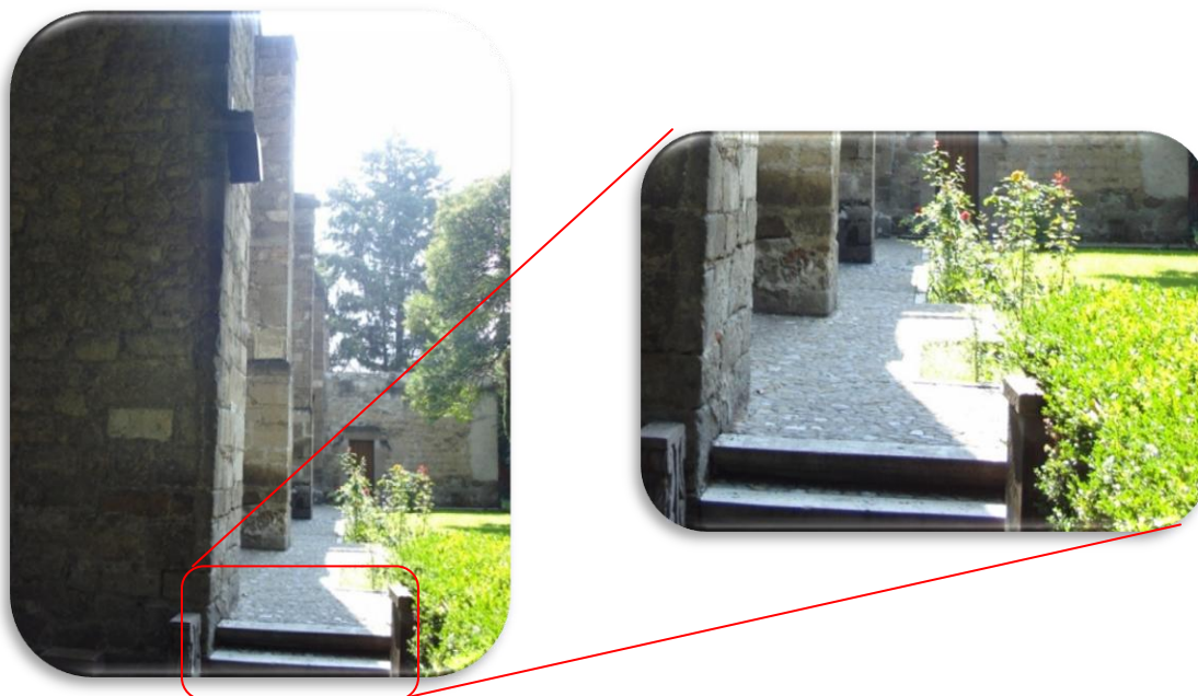
Foto 14. Con la remodelación que se hizo a la llegada del primer párroco del pueblo, se construyó un camino que rodea el edificio.
