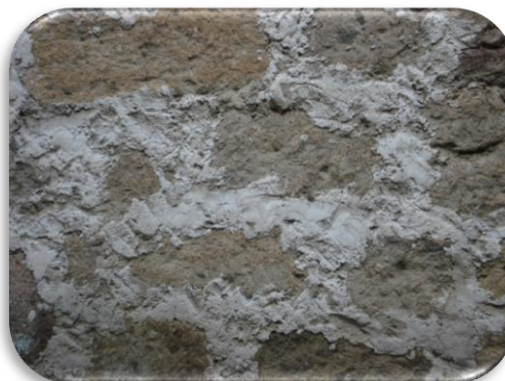
Foto 2. Mezclas diversas utilizadas para resane de juntas.
