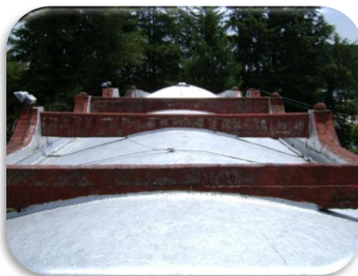
Foto 10. La bóveda de cañón corrido construida de concreto armado sustituyó una techumbre de bóveda catalana en 1950.
