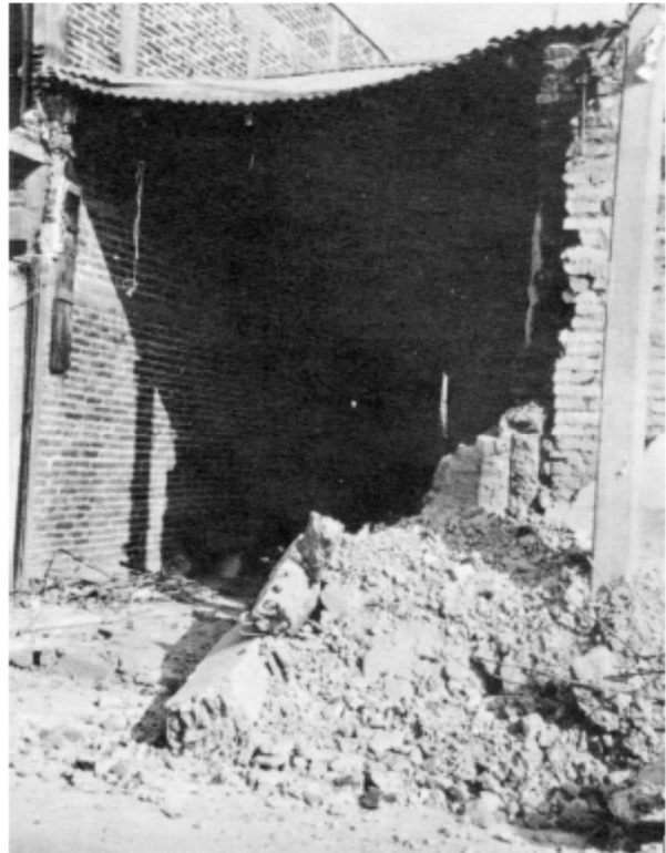
Imagen 2.11 Inadecuada conexión de muros de mampostería con elementos confinantes.
