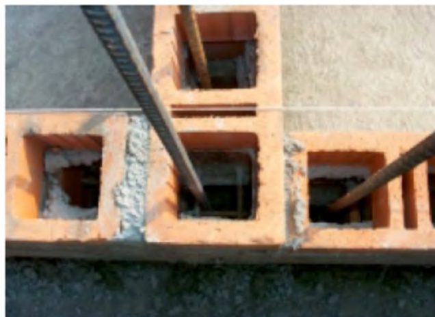
Imagen 2.13. Detalle de piezas huecas con refuerzo interior.
