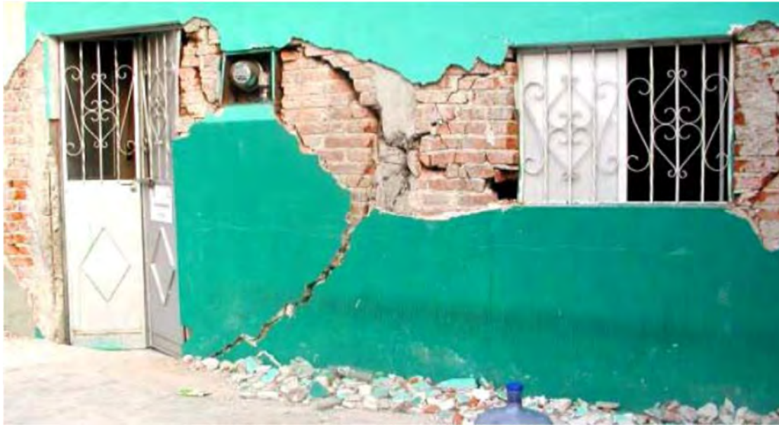
Imagen 2.18. Daño en aberturas no reforzadas por el sismo de Tecomán. Fuente: Sociedad Mexicana de Ingeniería Estructural.
