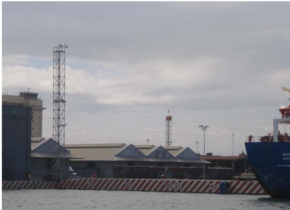
IMAGEN 99.- Actuales almacenes de la aduana
