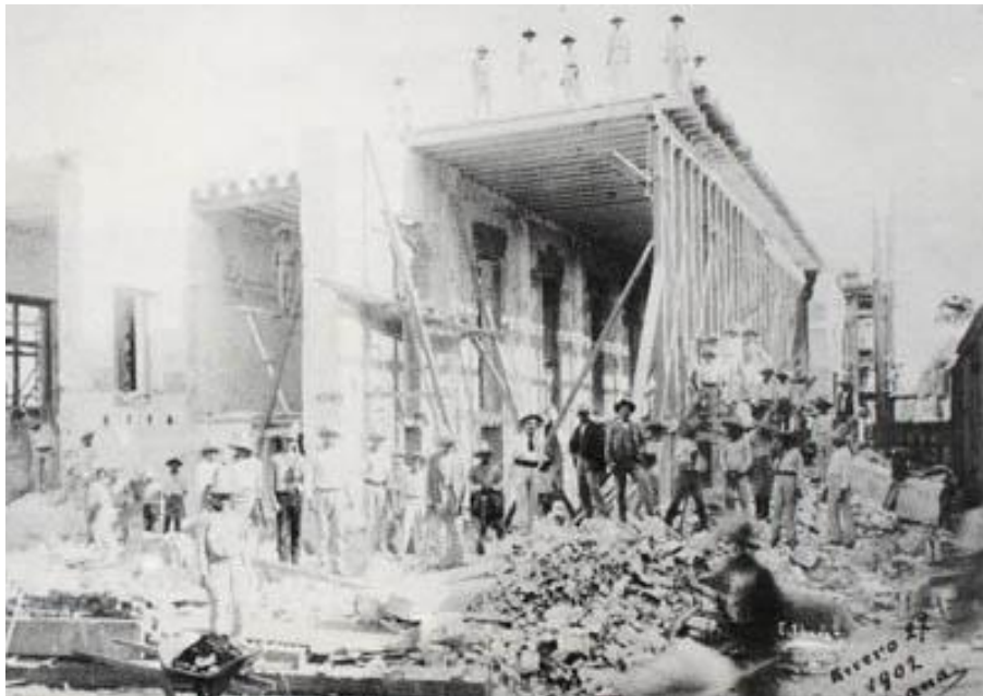
IMAGEN 103.- Construcción del nuevo edificio de la Aduana Marítima.
