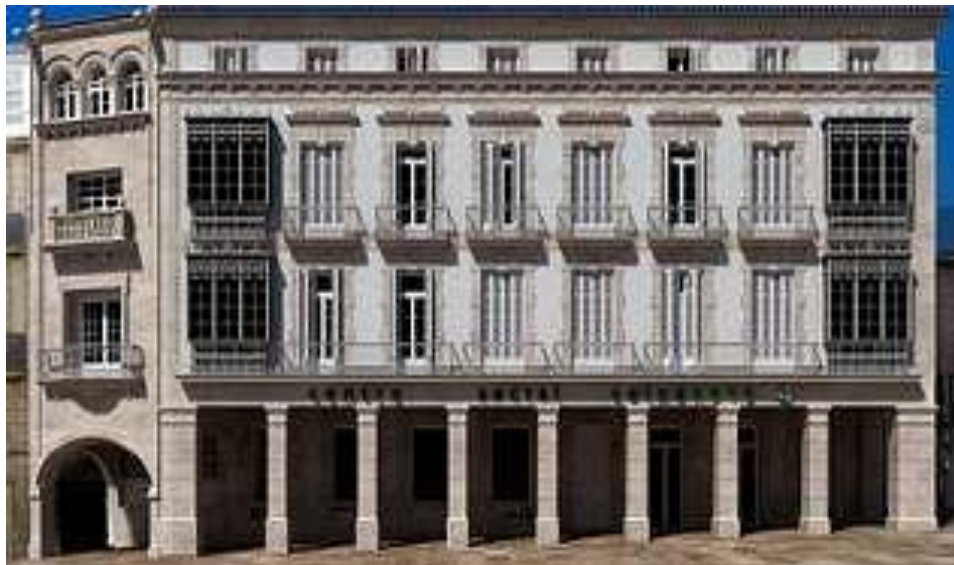
IMAGEN 92.- Fachada principal del edificio del Pilar.
