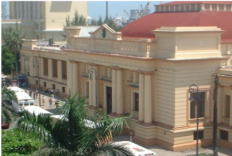
IMAGEN 64.- Fachada principal Estilo Neoclásico (Aduana Marítima).
