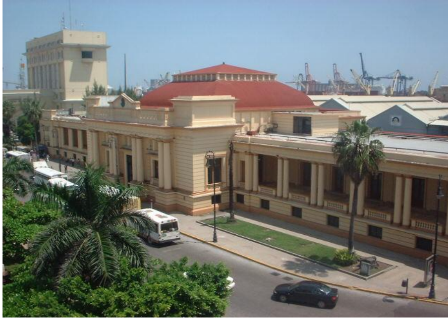
IMAGEN 65.- Vista general del edificio Aduana Marítima.
