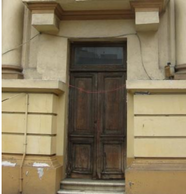
IMAGEN 106.- Desgaste de pintura
