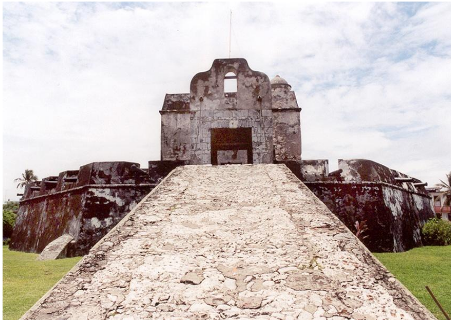
IMAGEN 22.- Baluarte de Santiago, parte de muralla conservada.
