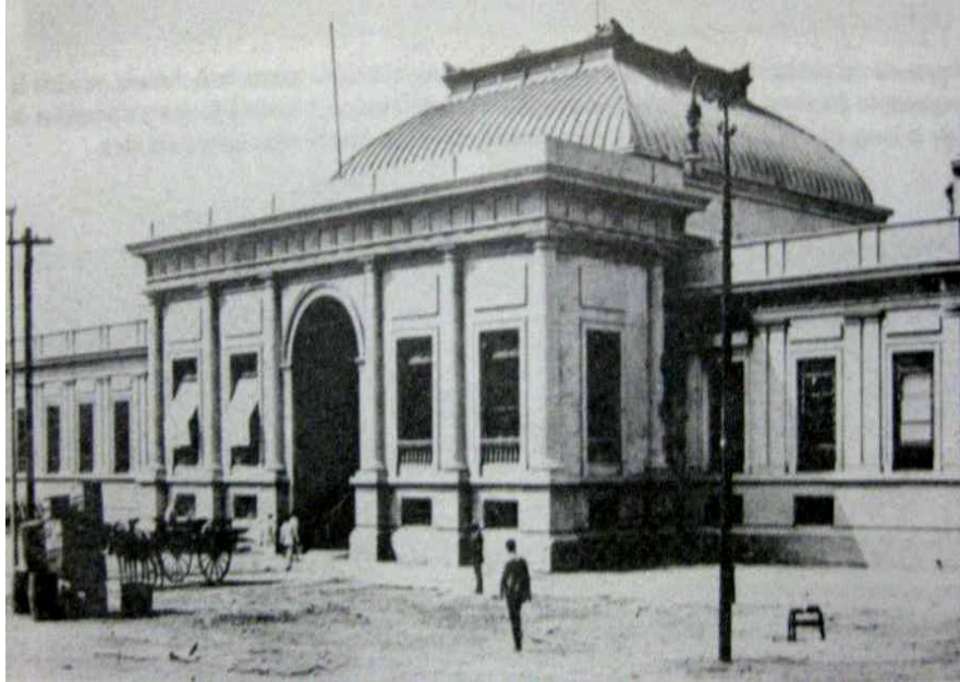
IMAGEN 11.- Antigua fachada principal de la Puerta de Mar.
