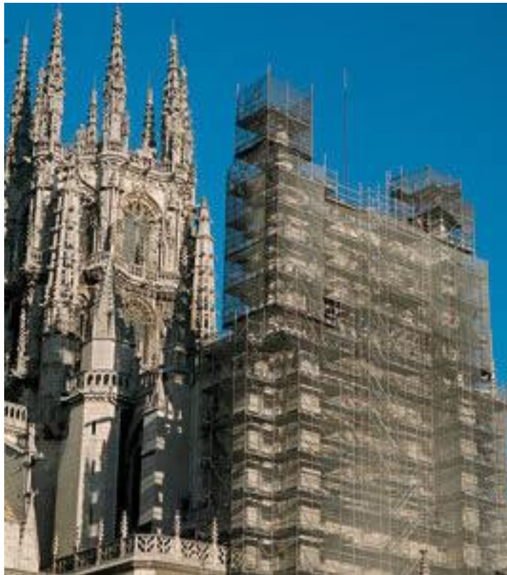
IMAGEN 46.- Catedral de Burgos en proceso de restauración.
