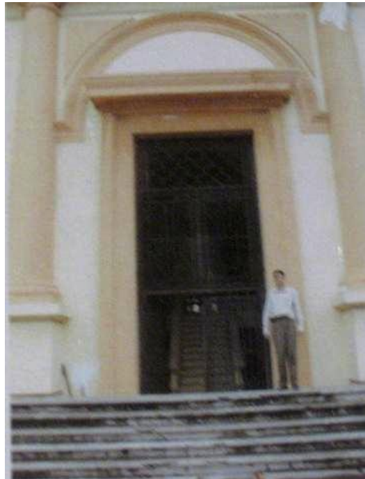
IMAGEN 105.- Perdida del arco de la puerta de mar.
