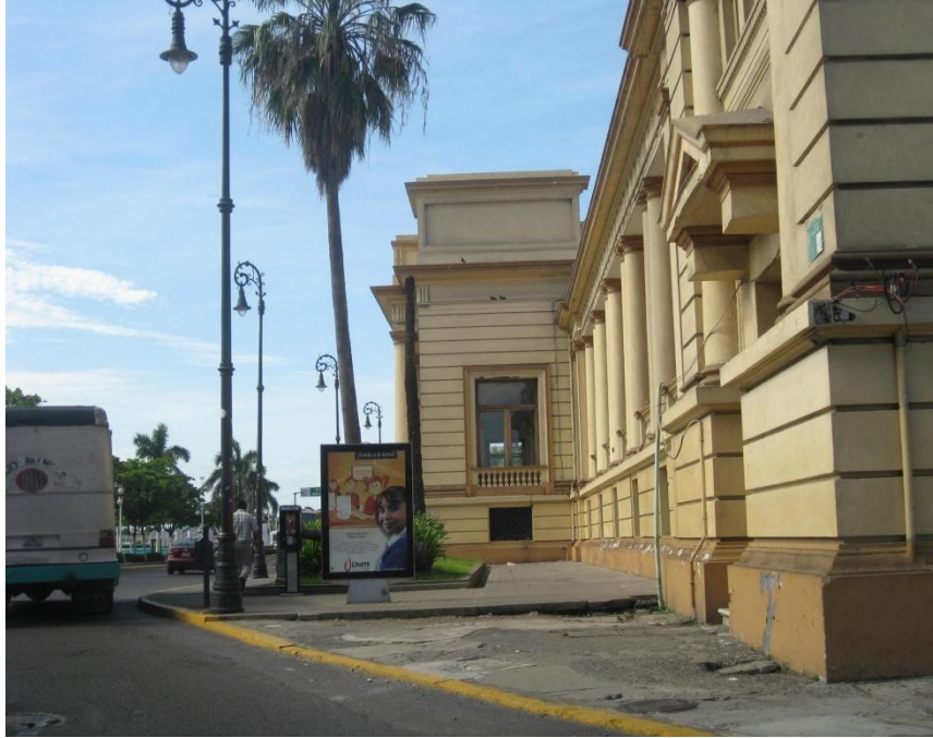
IMAGEN 110.- Pavimentación de banquetas dañada y maltratada.
