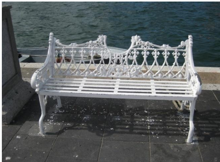
IMAGEN 115.- Bancas en mal estado.
