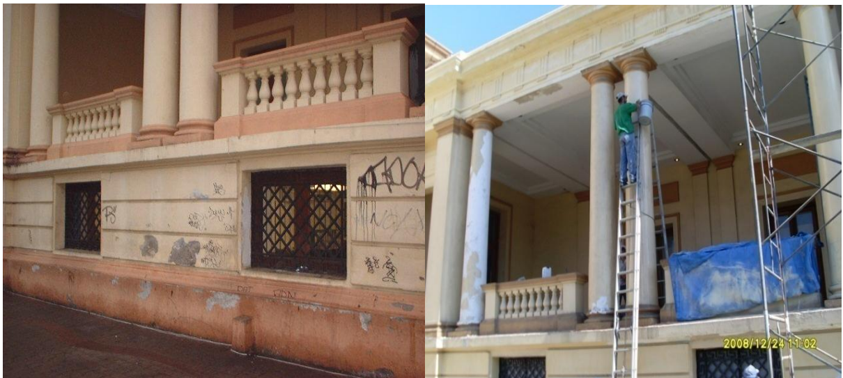
IMAGEN 62.- Fachada principal de la Aduana Marítima en gran deterioro.
