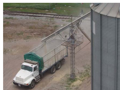
Foto 7.19 Área del centro de acopio donde se llena el camión de grano
