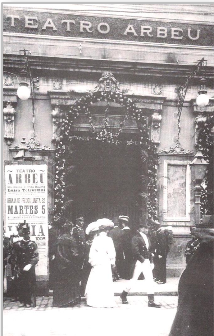
Detalle de la Fachada
