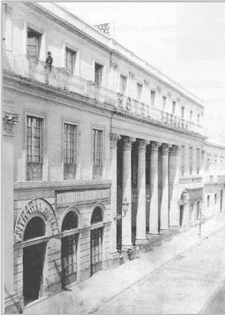
Fachada Fotografía de 1870
