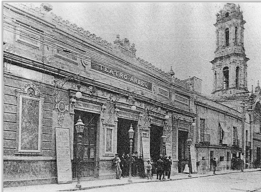
Fachada. Fotografía de 1875
