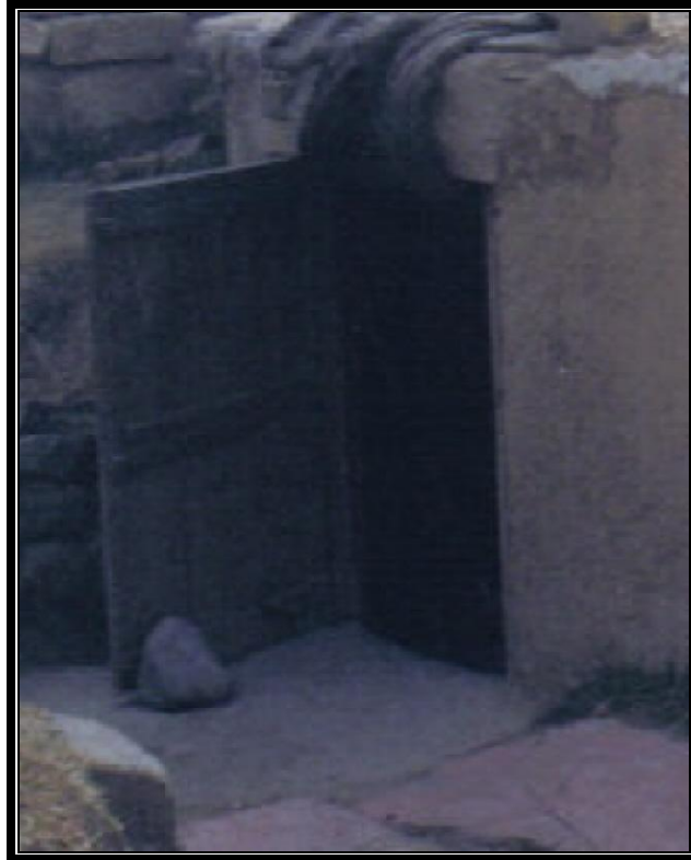
Figura 14. Puerta de entrada al baño de Temazcal
