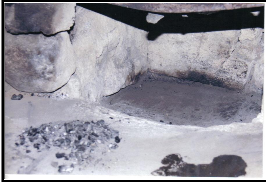
Figura 13. Vista de la hornilla donde se coloca la leña.
