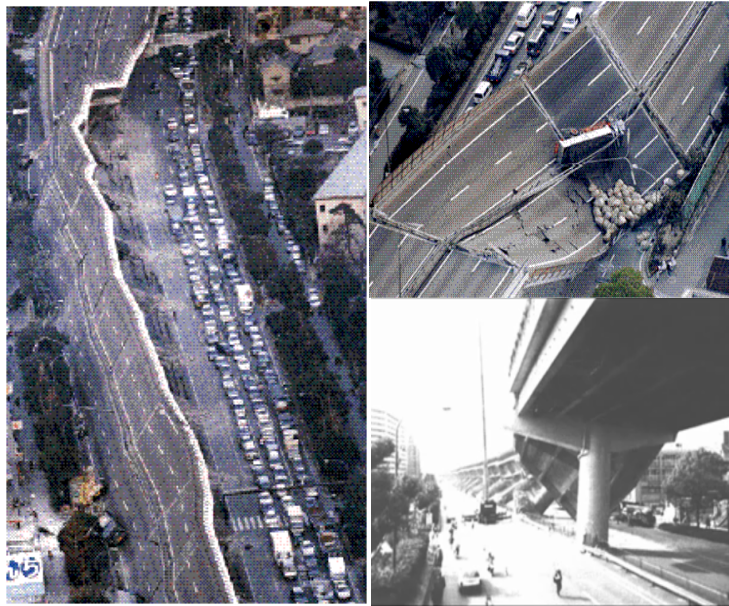
Figura 1.1 Daños en la sección de una autopista durante el sismo de Kobe provocados por la incoherencia de los movimientos del terreno
