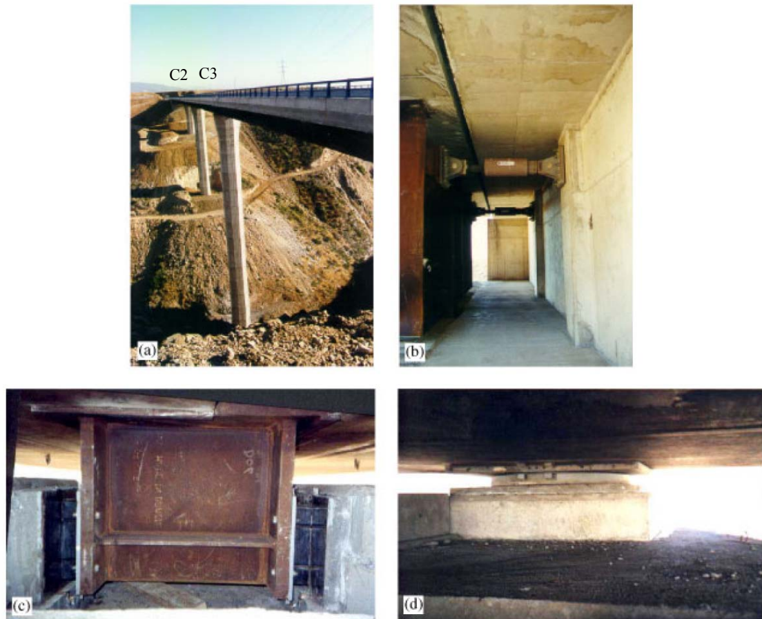
Figura 4.19 Puente Amolagas: (a) Vista panorámica general (b) amortiguadores (c) apoyos deslizantes y (d) apoyos de fricción (Sarrazin et al. , 2005)
