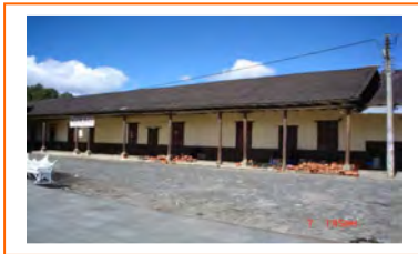
Fachada Escuela Primaria.
