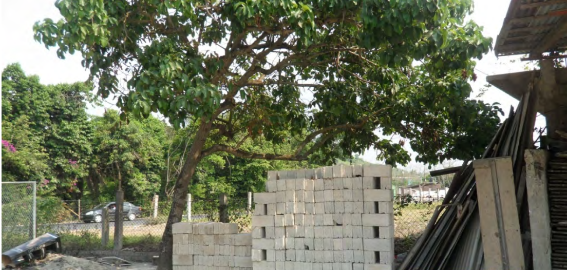
FIGURA 20 Columnas de block.
