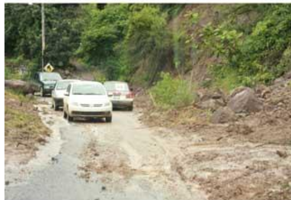
Foto 3.4.- Derrumbe en el camino.
