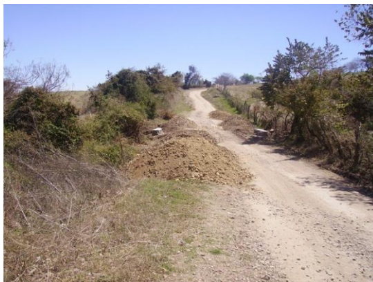
Foto 3.2.- Terracerías del camino.
