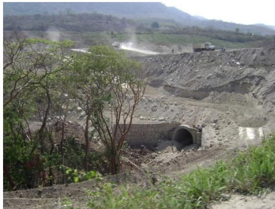
Foto 3.1.- Construyendo una alcantarilla.
