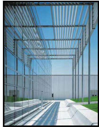
FIG. XLIII. Extraída con fines didácticos. Fachada este con las escaleras de emergencia. Protección solar. Fuente: Arquitectura Ecológica, Dominique Gauzin-Mülller.
