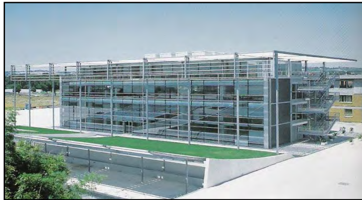
FIG. XLII. Figura extraída con fines didácticos. Vista general de la fachada sur. En primer plano, las plazas de estacionamiento a la sombra. Fuente: Arquitectura Ecológica, Dominique Gauzin-Müller
