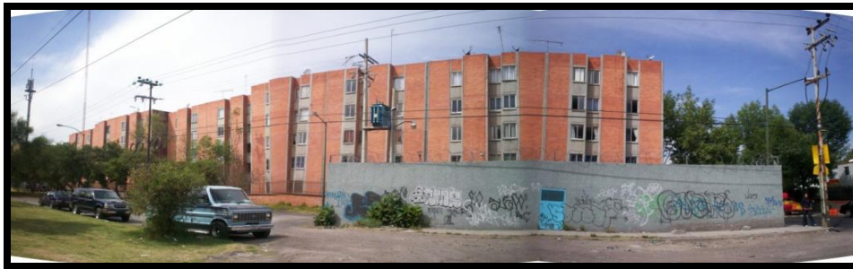
Larguillo de edificio tipo (en colindancia poniente). #3
