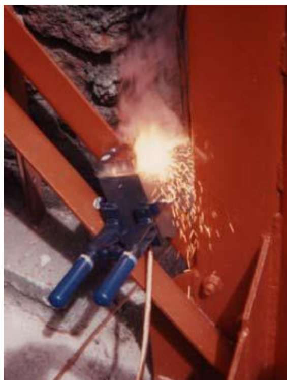
Figura 4.4 Soldadura exotérmica
