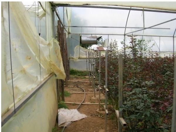
IMAGEN No. 16. Tutores metálicos y plástico en malas condiciones
