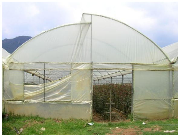
IMAGEN No. 9. Estructura de PTR de un Invernadero Tecnificado
