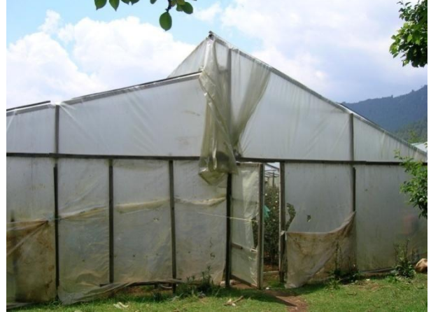
IMAGEN No. 15. Invernadero semitécnico con deficiencia en el manejo estructural y fitosanitario
