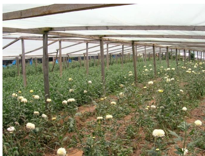
IMAGEN No. 5. Invernadero rustico con cubierta de plástico y estructura de madera
