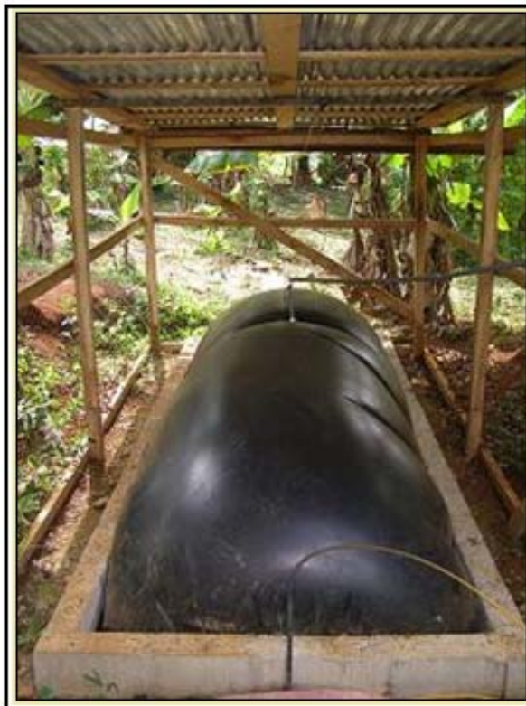
Figura 2.22 Digestor de flujo-tapón o salchicha (Reciclable, 2009)
