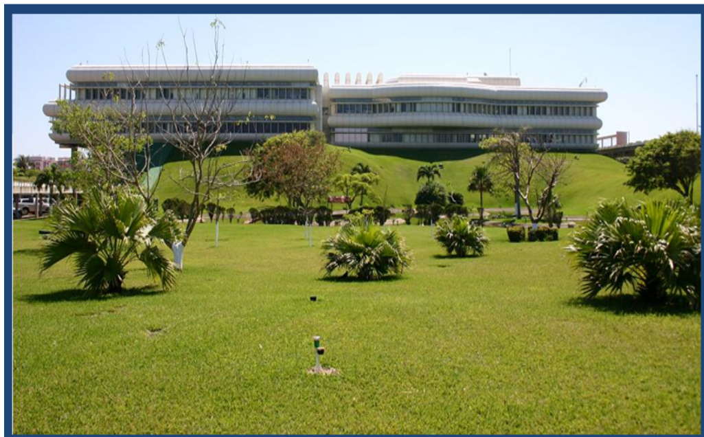
FIGURA 3.2 Edificio de Pemex Petroquímica
