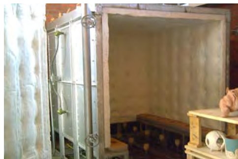
209 Interior del horno.
