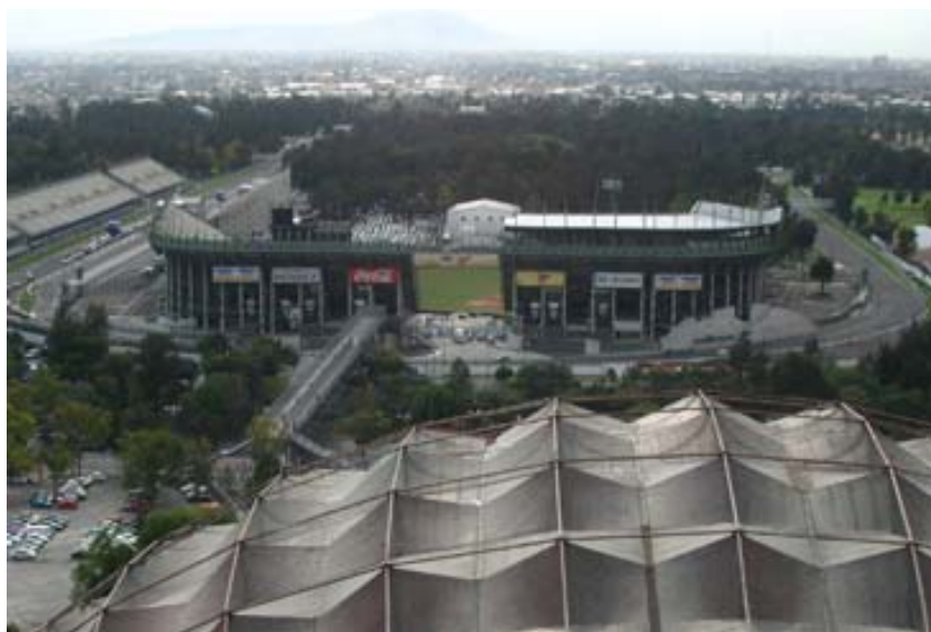
Fotografía desde el Palacio de los deportes, se aprecia la el Foro Sol, a la izquierda tribunas frente a pits, al fondo tribunas sobre pits y las obras secundarias como son puertas de acceso y el muro curvo.
