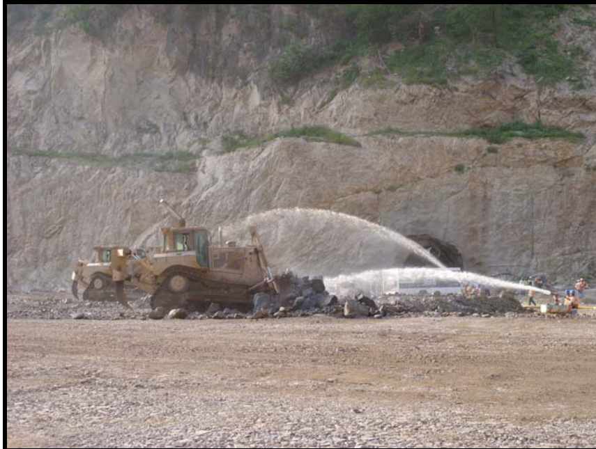
Fig. no. 26.- Colocación y humectación de materiales en la cortina.
