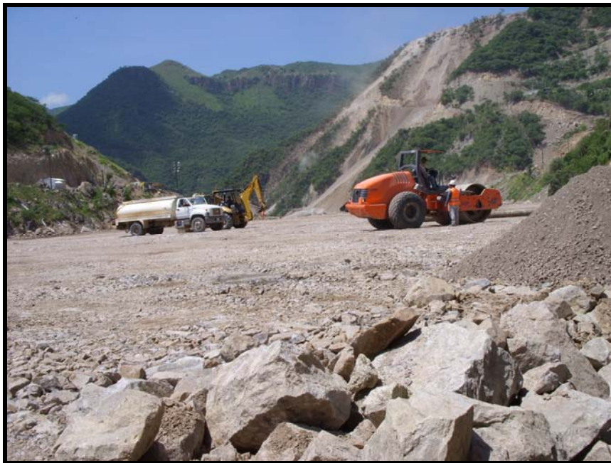
Fig. no. 27.- Compactación de los materiales colocados en la cortina.
