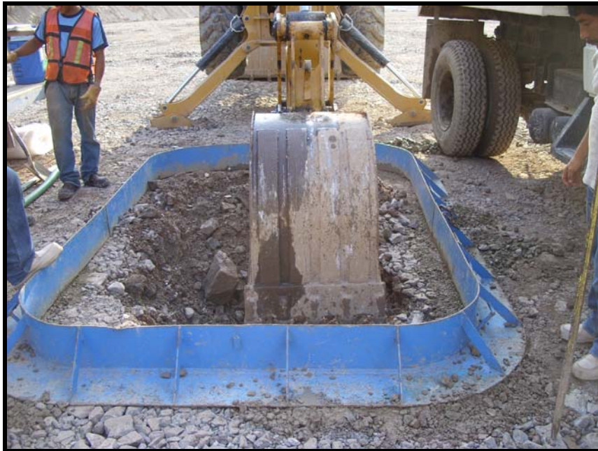
Fig. no. 30.- Inicio de la excavación.
