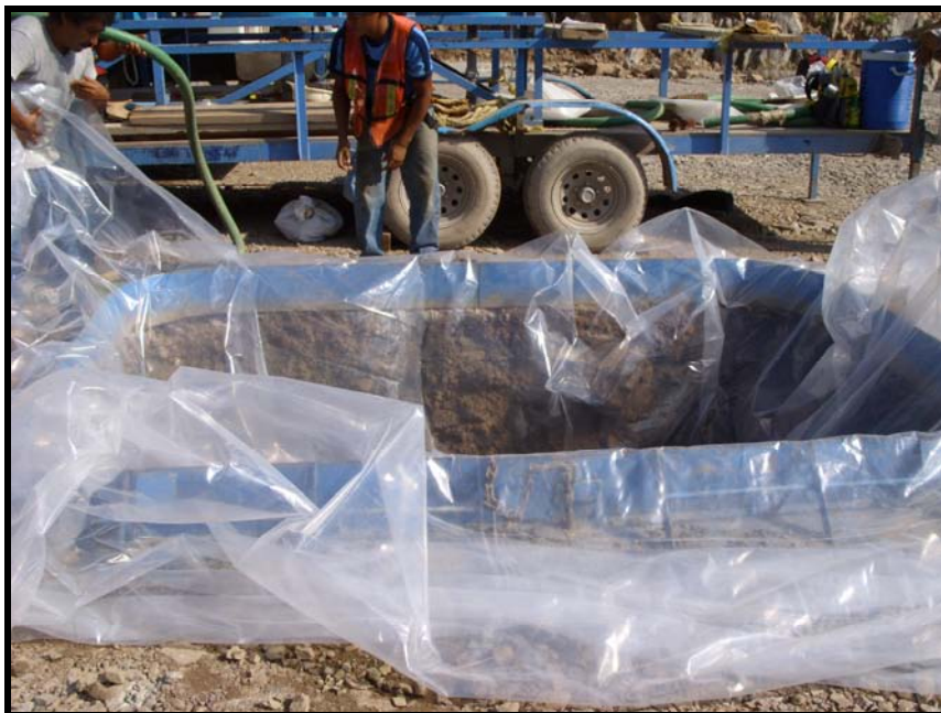
Fig. no. 33.- Colocación del polietileno.
