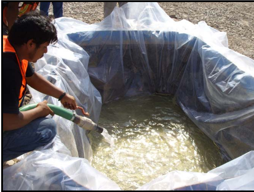
Fig. no. 34.- Llenado del pozo.
