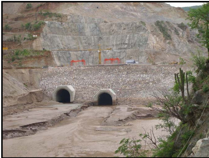
Fig. no. 5.- Obra de desvío sobre el Río Santiago.
