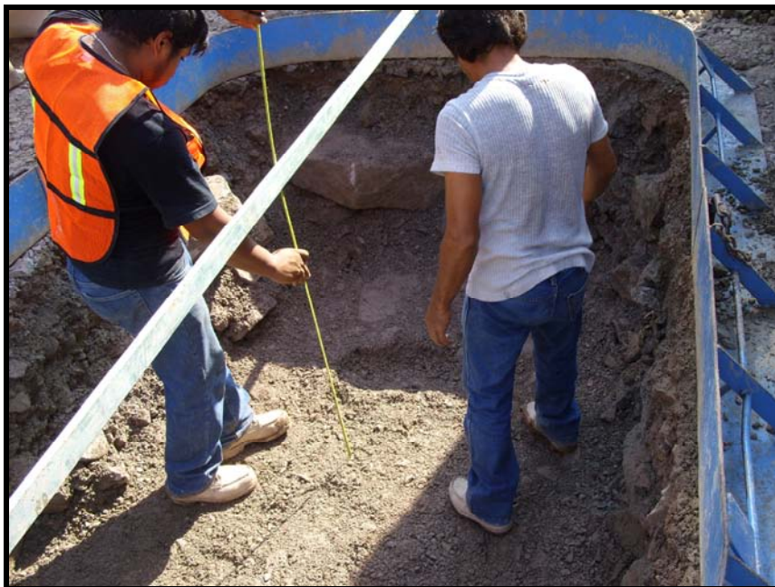
Fig. no. 31.- Comprobando la profundidad requerida para la prueba.
