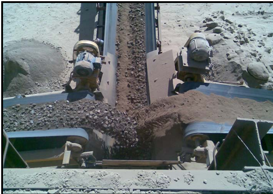
Fig. no. 11.- Banda transportadora de materiales hacia el mezclador.
