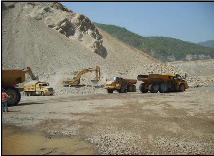
Fig. no. 20.- Limpieza del cauce del Río Santiago.
