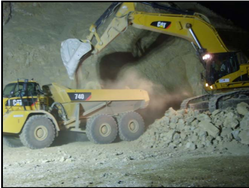
Fig. no. 13.- Extracción del aluvión en el canal de desfogue.
