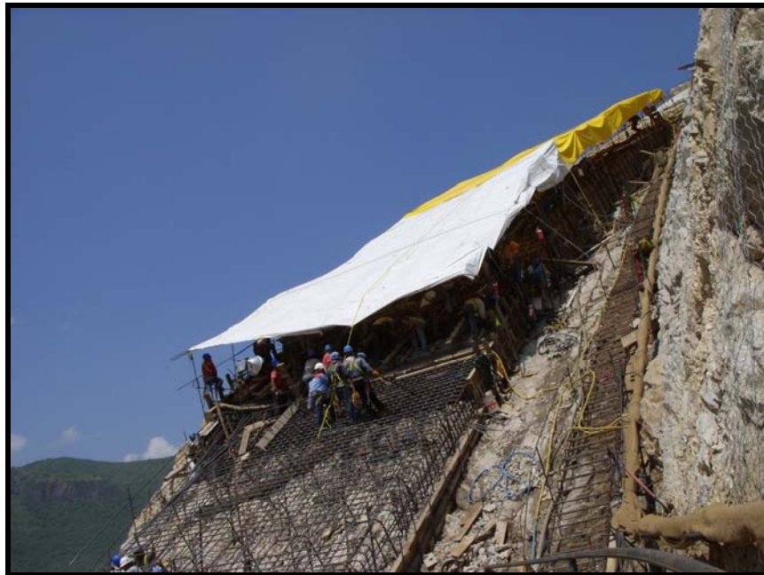
Fig. no. 21.- Construcción del plinto en la margen izquierda.
