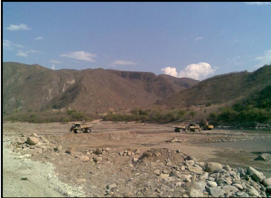
Fig. no. 7.- Extracción del aluvión.
