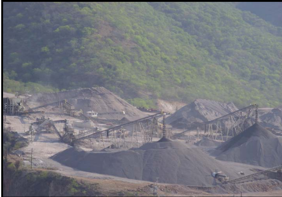
Fig. no. 8.- Vista panorámica de la planta de trituración.
