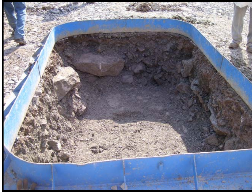
Fig. no. 32.- Pozo listo para iniciar el llenado.
