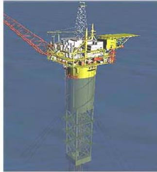
Figura 1.5.- Plataforma tipo SPAR
