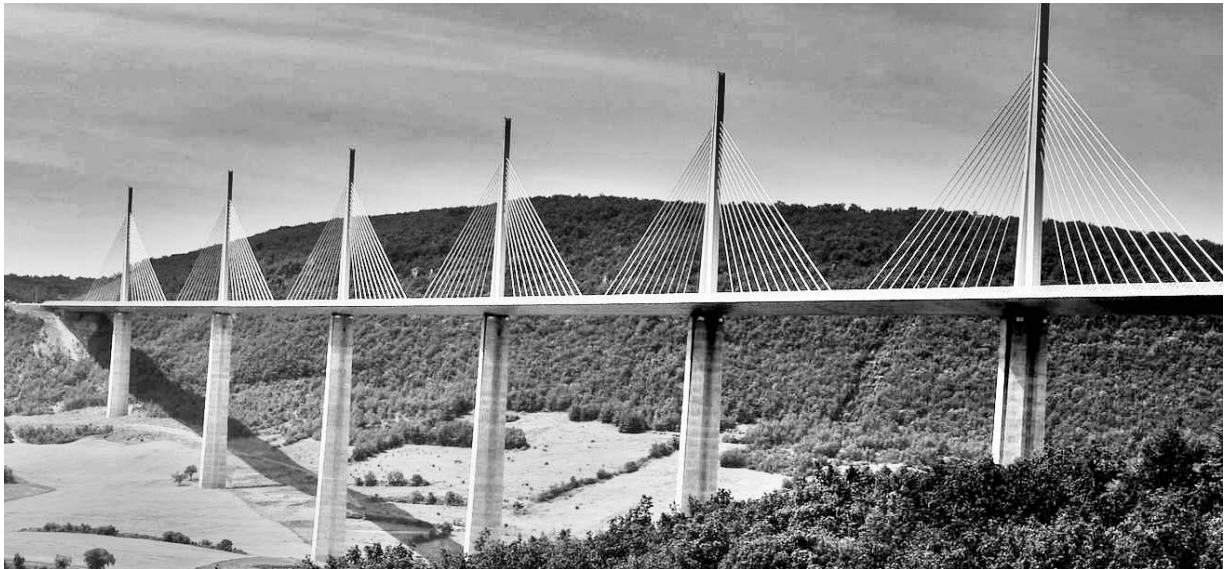
Fig.2.5 Viaducto Millau en Francia.
