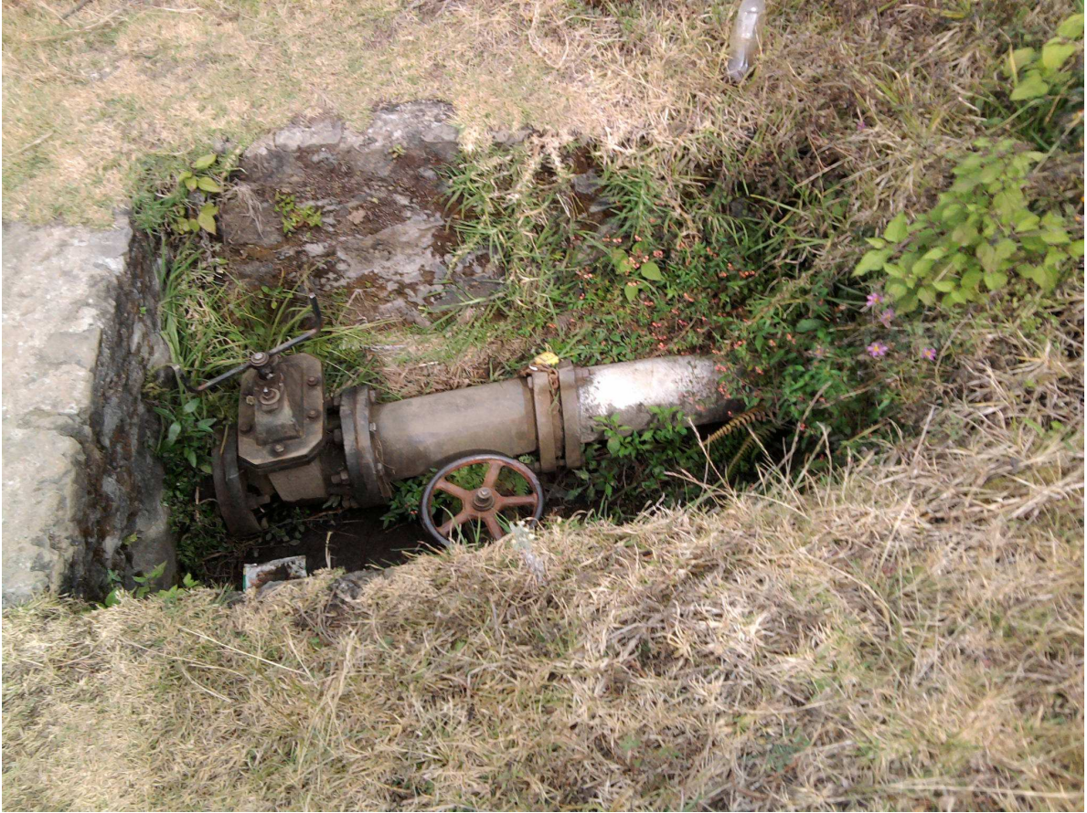
Foto 8.- Control de agua a través de válvulas.
