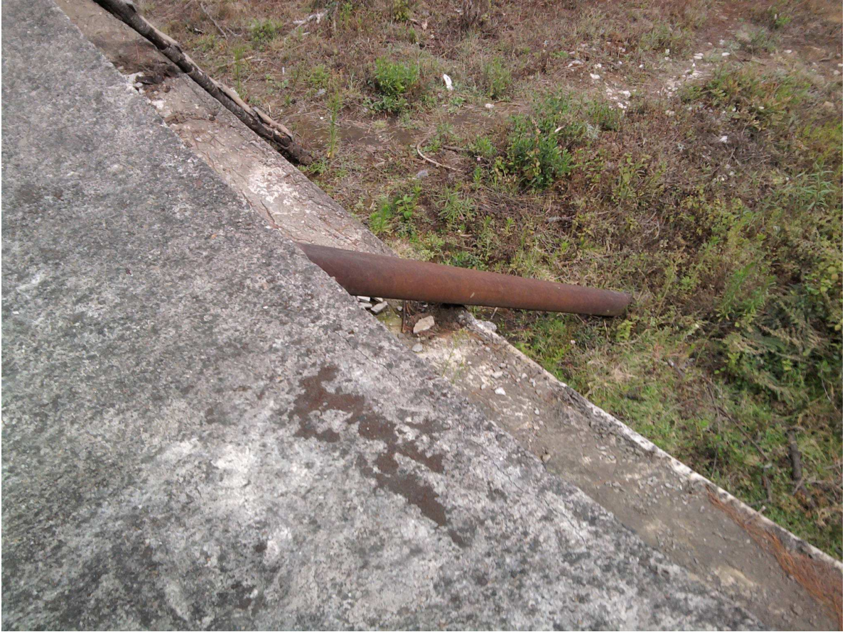
Foto 7.- Tubería de llegada al tanque de almacenamiento de agua.
