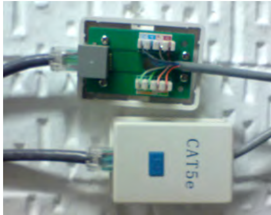
Figura 5.9. Fotografía de dos puntos de consolidación mediante el uso de rosetas.
