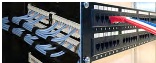
Figura 5.12. Paneles de Parcheo.
