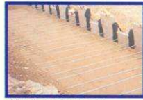
Vista de armadura de acero.
