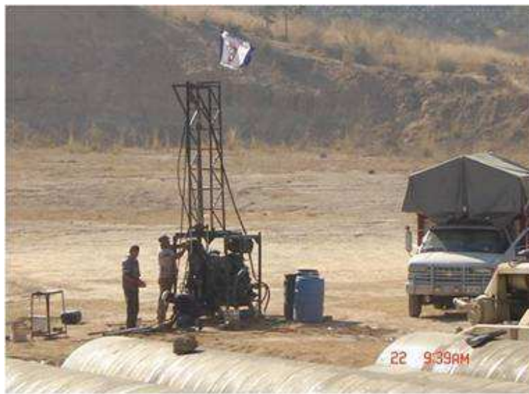
SONDEO EXPLORATORIO SPT - 1, REALIZADO EN EL FRACCIONAMIENTO INDUSTRIAL SAN MARTIN
