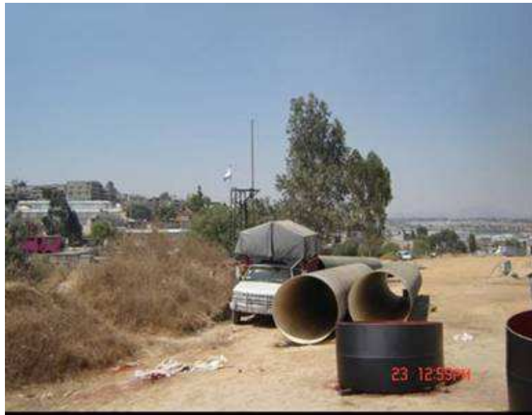
EXCAVACION DEL POZO A CIELO ABIERTO NUMERO 7
