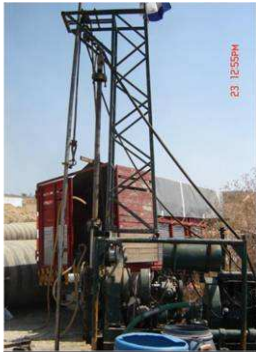
TRABAJOS REALIZADOS PARA LA EXCAVACIÓN DEL POZO A CIELO ABIERTO PCA-6
