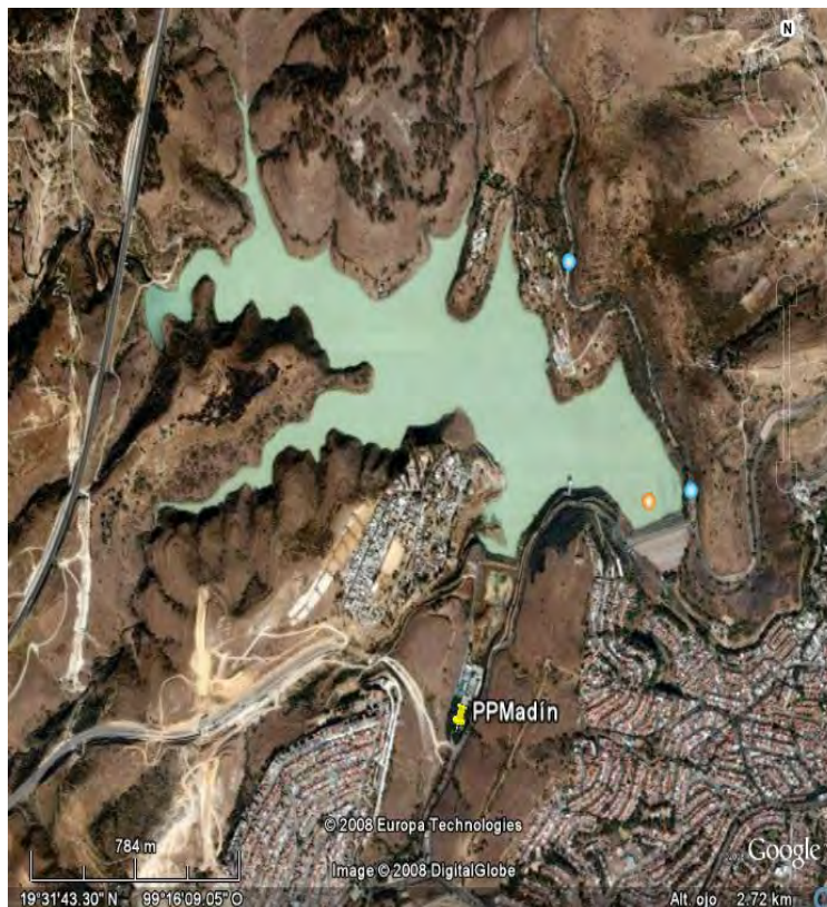
Figura 1. 1 Vista satelital de la presa Madín (Google Earth, 2008).
