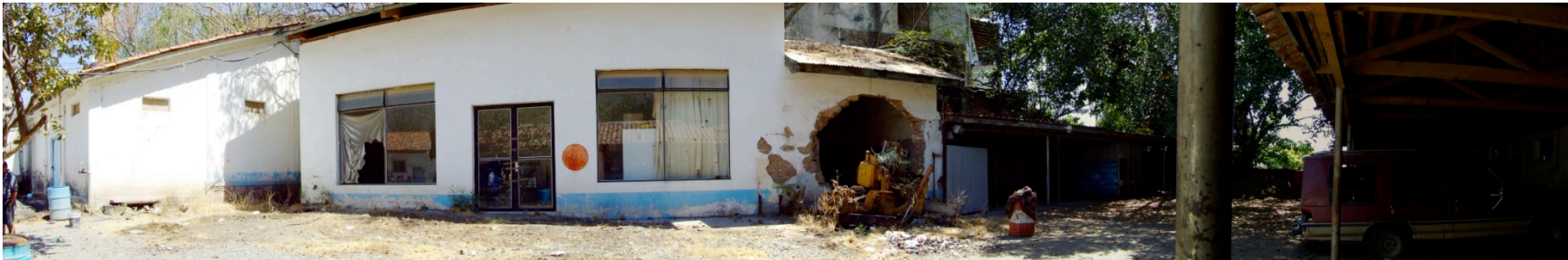
Vista panorámica zona de estacionamiento y patio de maniobras.
