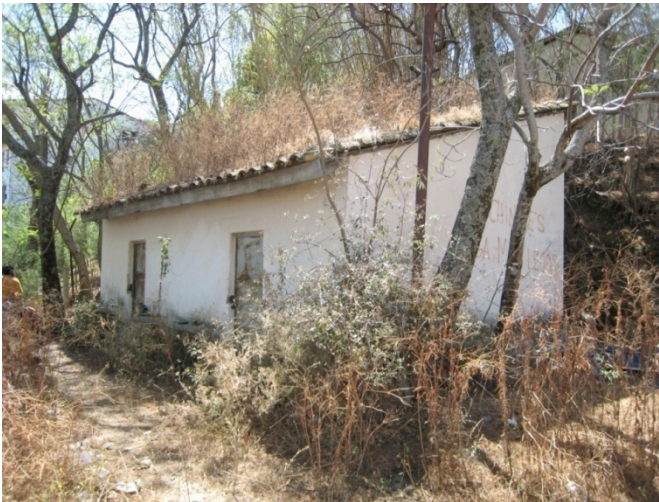
Construcción ubicada al fonde del patio principal.
