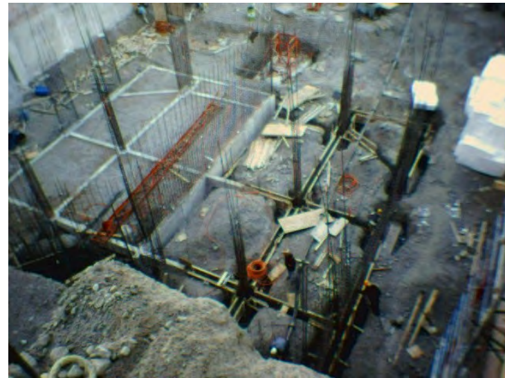
Fig. 20 Mitad de cimentación de N-28.30 colada y preparaciones para el colado de la 2ª mitad.
