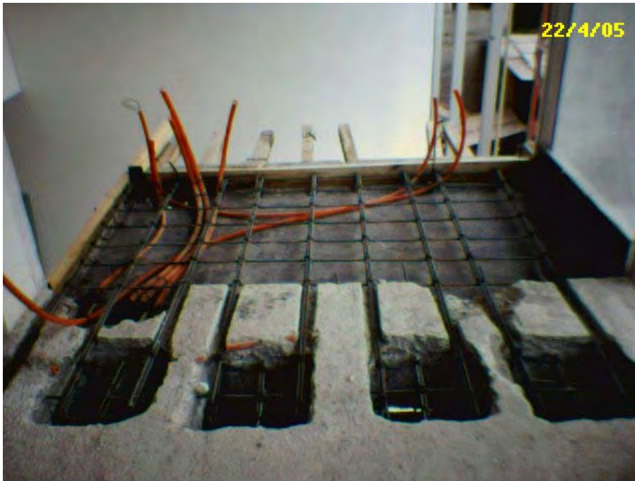
Fig. 136 y 137 Trabajos de ampliación de la recámara principal. Adicionales contratados.
