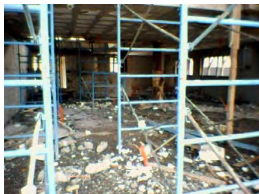
Fig. 86 Departamento en obra negra.
