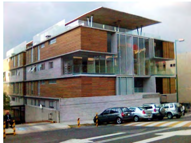
Fig. 114 Edificio sur y norte terminado.
