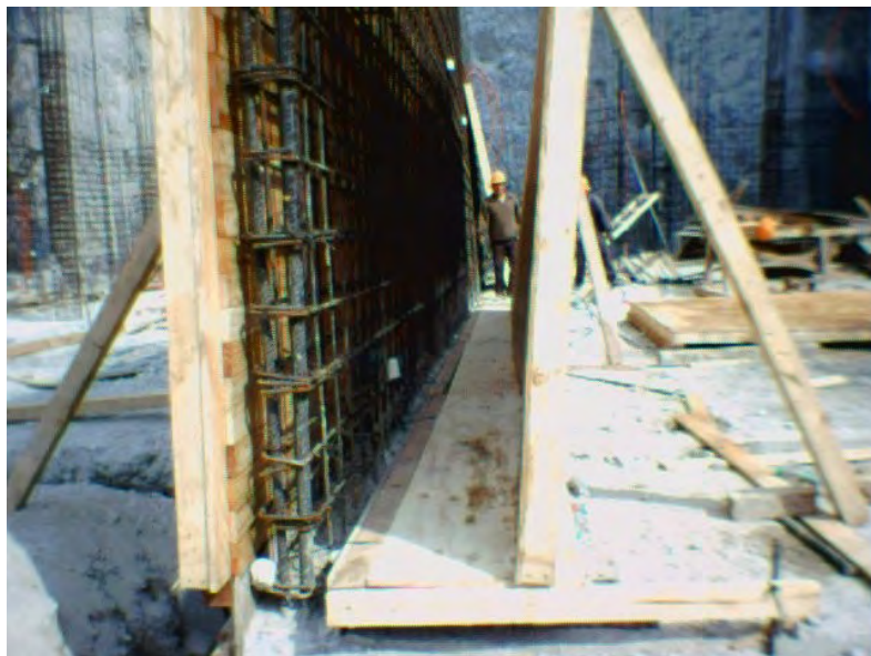
Fig. 40 Cimbra para muro de concreto aparente con acabado dueleado.
