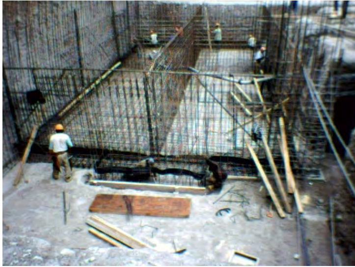
Fig. 30 Colocación de banda ojivada.
