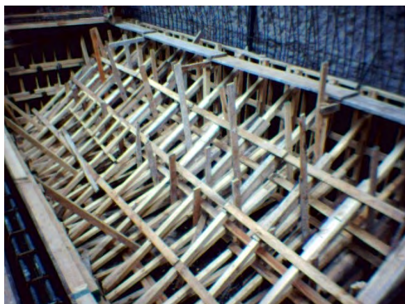
Fig. 32 Detalle de apuntalamiento de contramuro.
