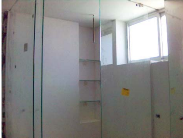
Fig. 98 Lambrin de mármol caliza, cancel y entrepaños de vidrio Templado baño principal.
