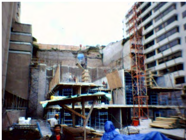
Fig. 44 y 45 Módulos de cimbra para forjado de muros de concreto.
