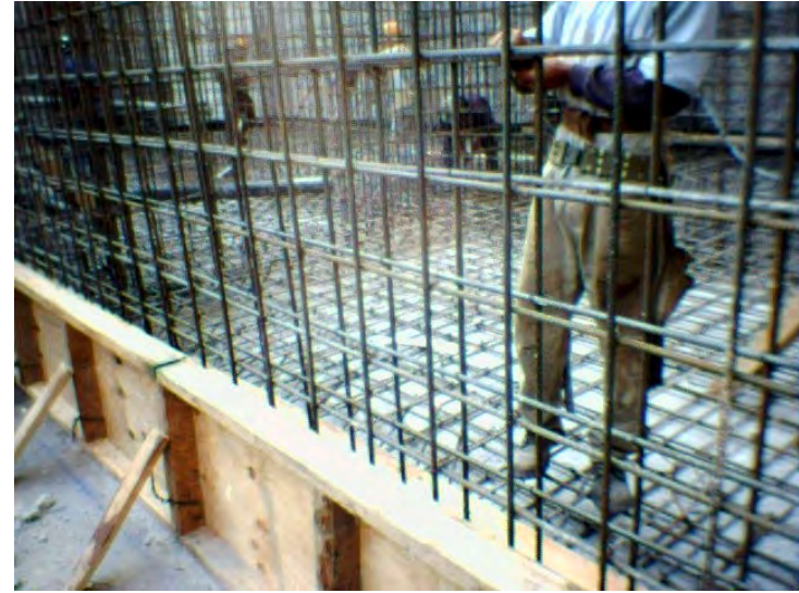
Fig. 31 Cimbra en costado para colado de losa fondo.
