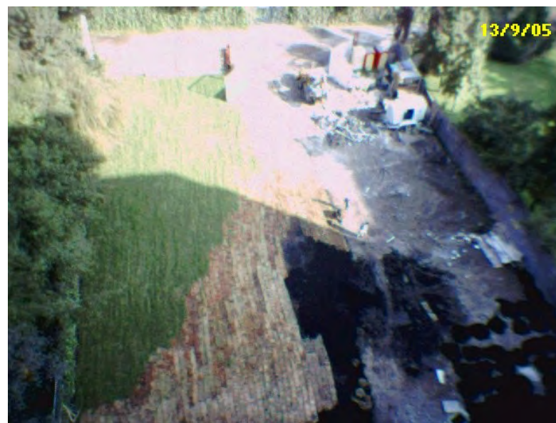
Fig. 150 Zona federal liberada y en proceso de colocación de pasto.
