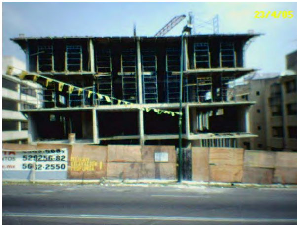
Fig. 138 Tapial delimitando la obra. Señalización de excavación profunda.
