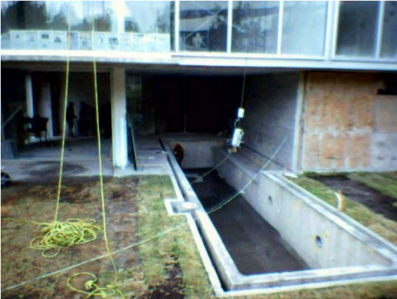
Fig. 103 Inicio de trabajos en área de amenidades.
