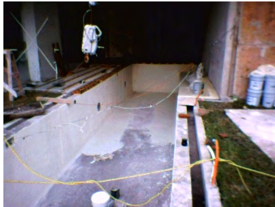
Fig. 104 Impermeabilización de nadador.
