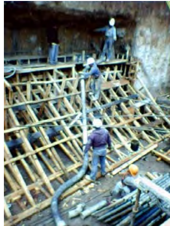
Fig.47 Colado de contramuro.
