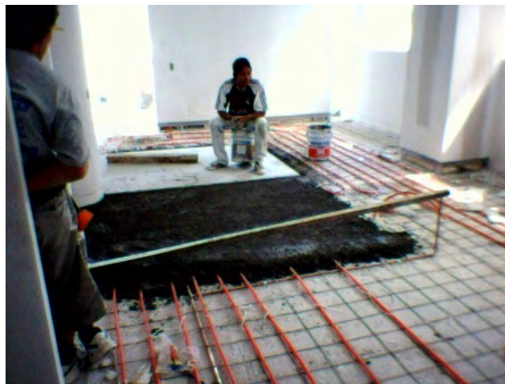
Fig. 92 Colocación de placas de mármol sobre manguera de calefacción.
