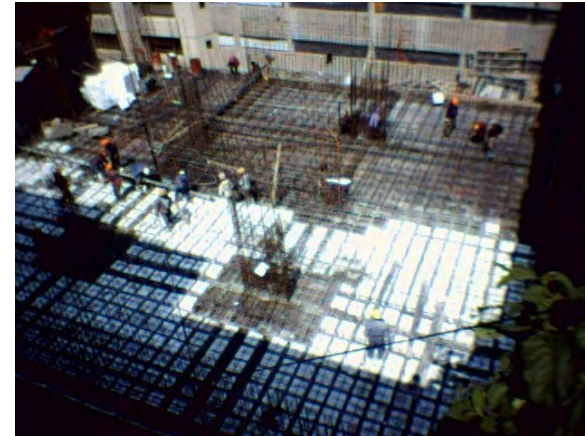
Fig. 56 Losa de estacionamiento edificio sur.
