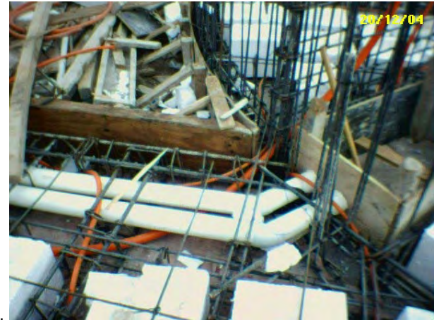
Fig. 70 y 71 Instalaciones ahogadas en losas.
