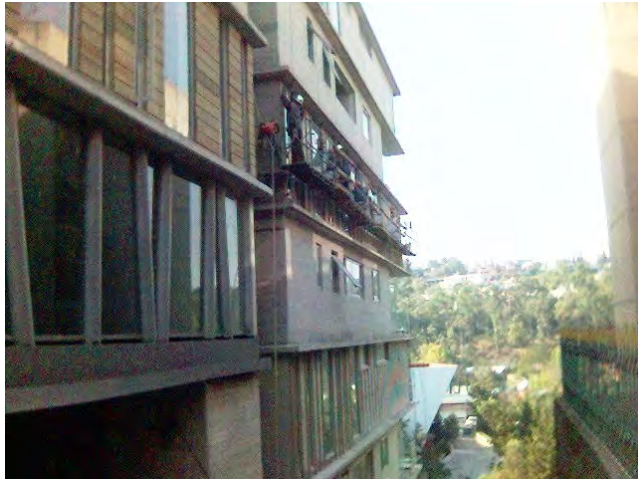
Fig. 137 Uso de arnés y línea de seguridad para trabajo en altura.
