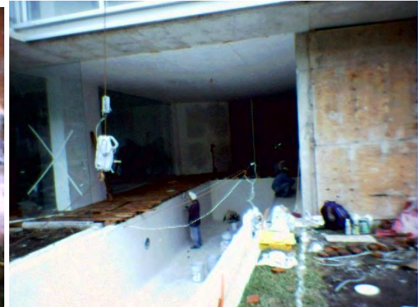
Fig. 105 Colocación de deck de madera, cancelería.
