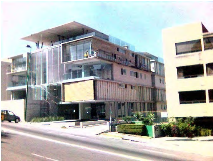
Fig. 111 Colocación de bastidor y madera en fachadas.
