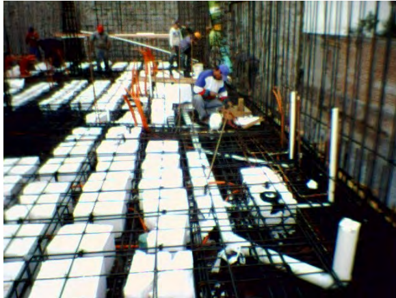
Fig. 70 y 71 Instalaciones ahogadas en losas.
