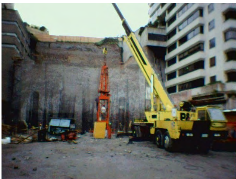
Fig. 36 Colocación de cabezal de torre grúa.
