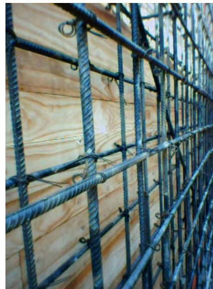
Fig. 41 Detalle de la cimbra dueleada.
