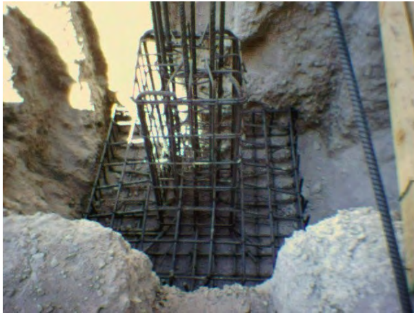
Fig. 21 Armado de zapata aislada.
