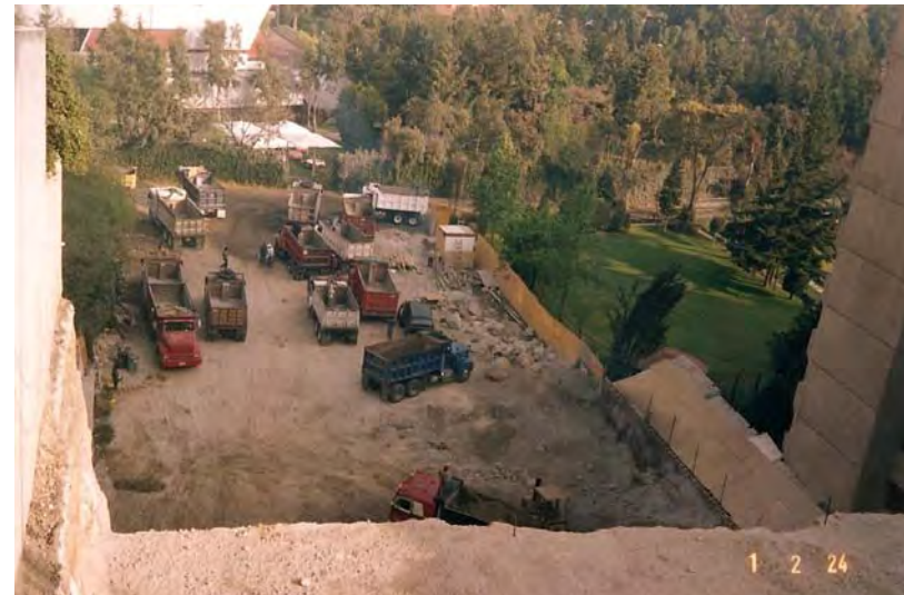
Fig. 10 Tapiales de protección. Vista desde N-12.40.
