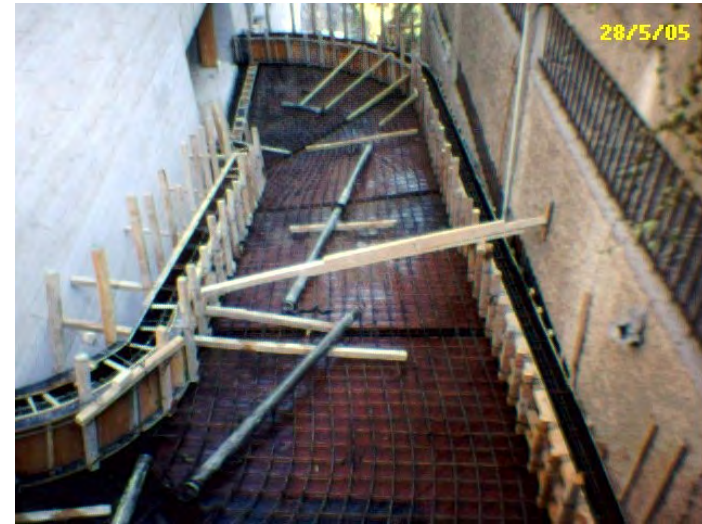
Fig. 69 Rampa lista para colado.
