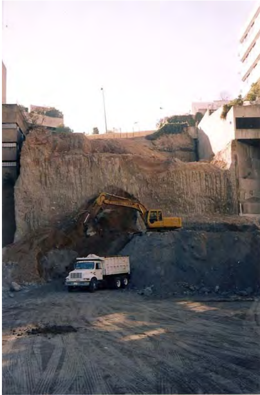
Fig. 12 Excavadora llegando a N-28.30.
