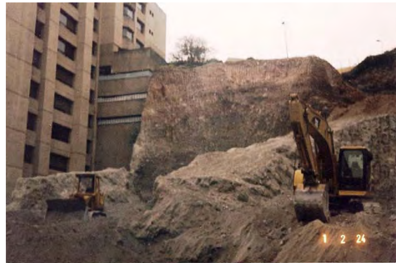
Fig. 8 Máquinas rebajando el nivel de terreno
