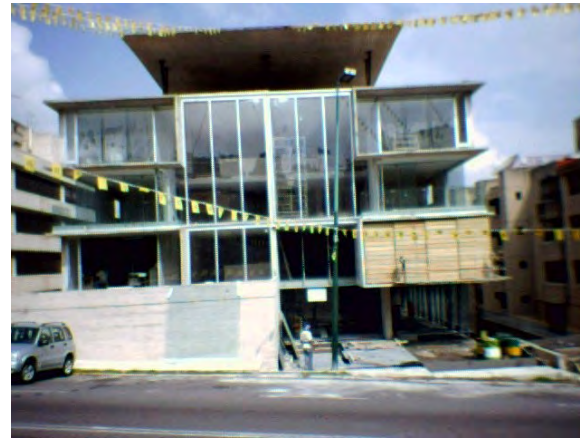
Fig. 95 Aluminio en fachada sur.
