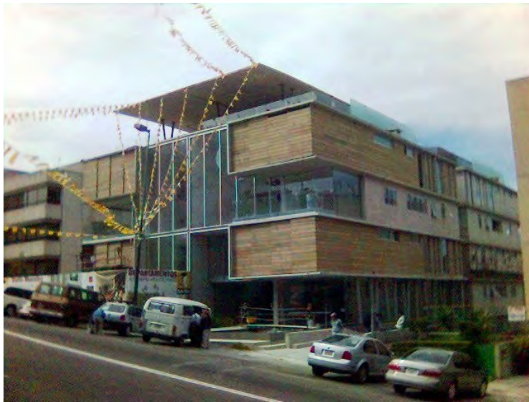
Fig. 113 Edificio sur terminado y trabajando en edificio norte al fondo.
