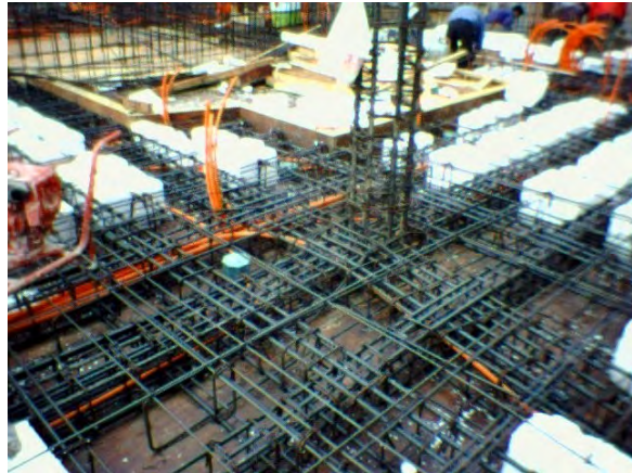
Fig. 55 Armado de nervaduras en losas.
