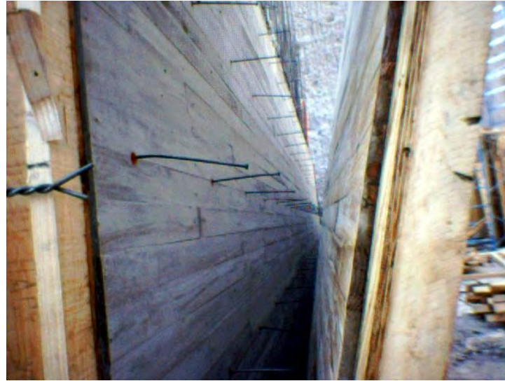
Fig. 42 Acabado del concreto con el dueleado.
