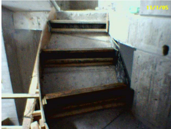
Fig. 93 Forjado de escalones en escaleras de servicio.
