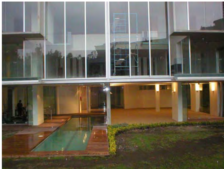
Fig. 106 Zona de nadador y salón de fiestas terminado.
