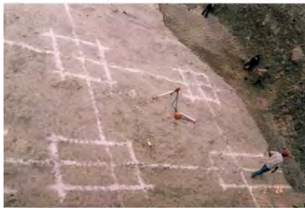
Fig. 14 Trazo de zapatas y ejes.
