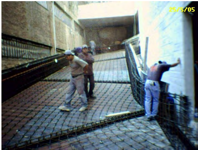
Fig. 68 Armado de losa fondo de rampa y traves.
