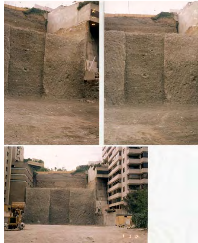
Fig. 13 Plataformas N-12.40 y N-28.30 terminadas.
