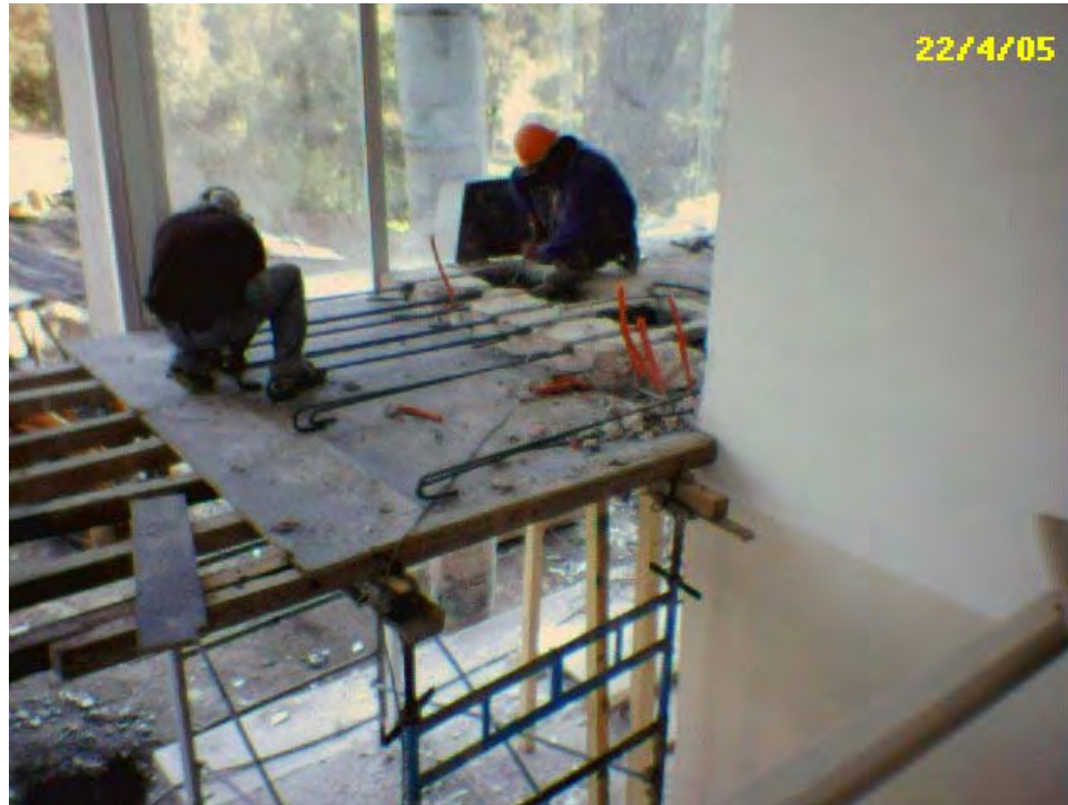
Fig. 135 Ampliación de recámara principal, trabajo adicional.
