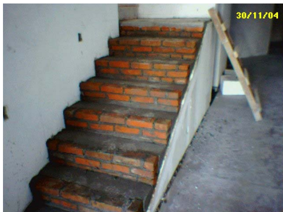
Fig. 88 Forjado de escalones en departamento.
