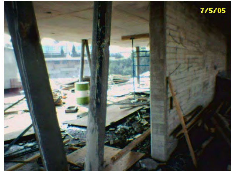
Fig. 60 Muro de concreto y columnas metálicas en PH.
