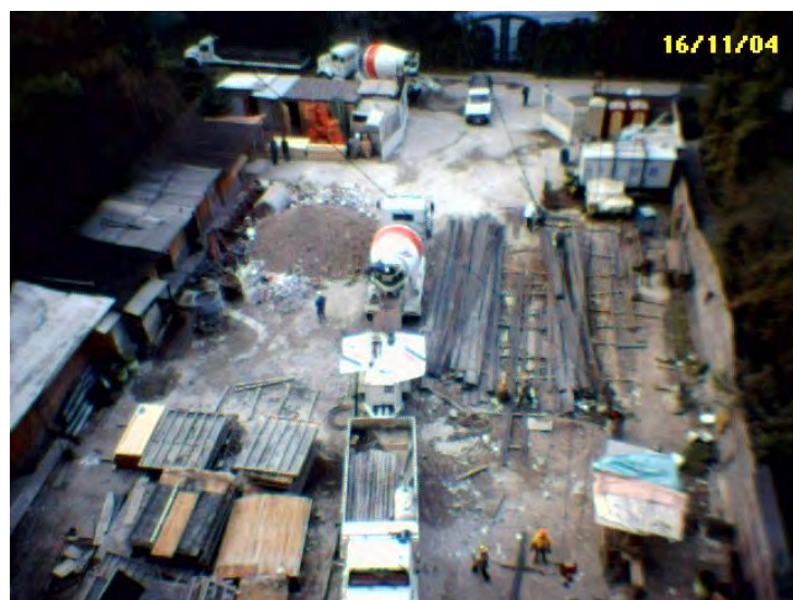
Fig. 149 Apilamiento de materiales y bodegas en zona federal.
