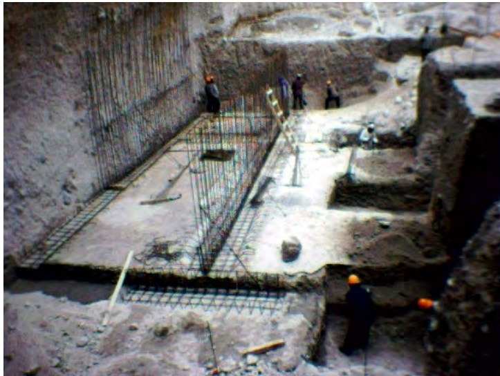
Fig. 27 Desplante de cisterna en plataforma N-12.40.
