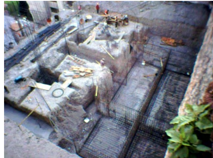
Fig. 28 Vista de cimentación en plataforma N-12.40.
