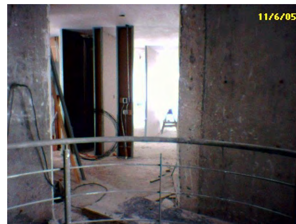
Fig. 89 Tablaroca a una cara para terminación de instalaciones.
