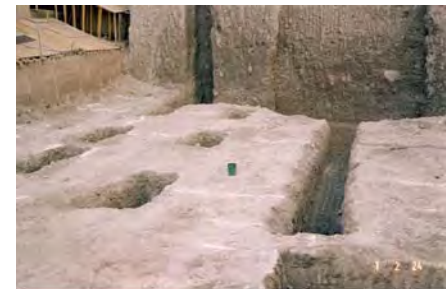
Fig. 16 Cepas para desplante de cimentación.
