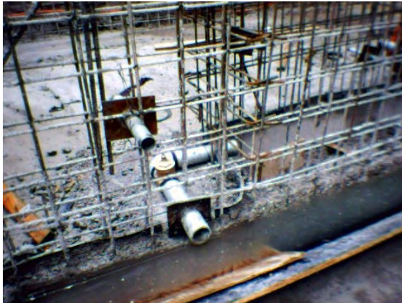
Fig. 79 Pasos en cisterna para conexiones posteriores.
