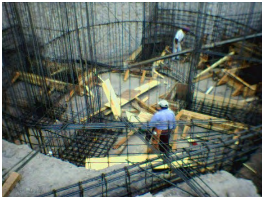
Fig. 23 Armado y preparaciones en zona de núcleo central.
