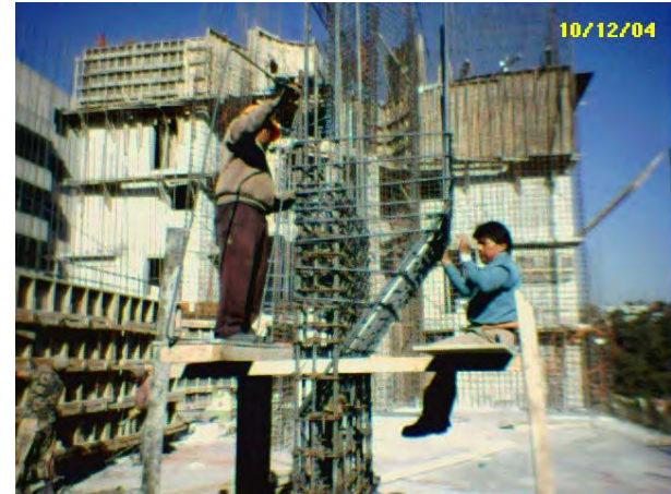
Fig. 48 Detalle de armado de columna desfasada.
