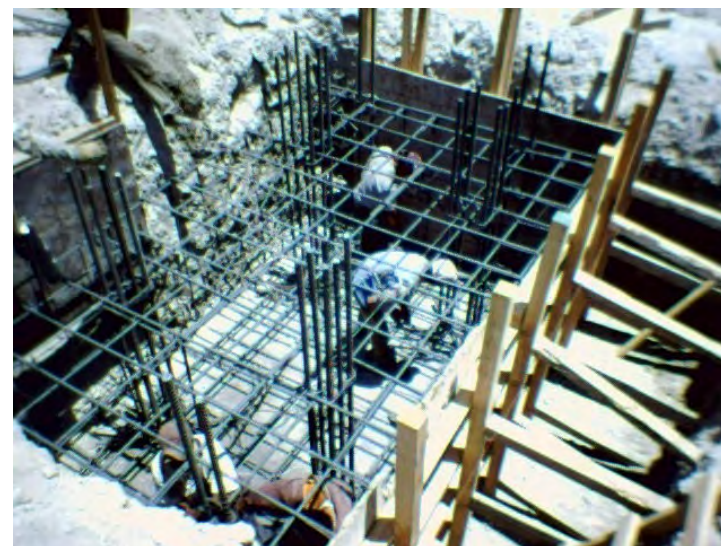
Fig. 25 Anclajes y cimbra de dado de torre grúa.
