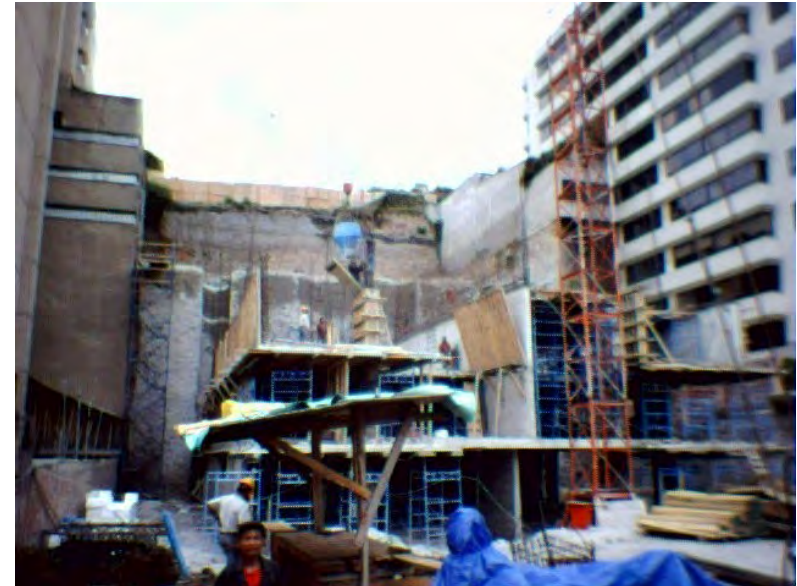
Fig. 39 Colado por medio de bacha concretera.
