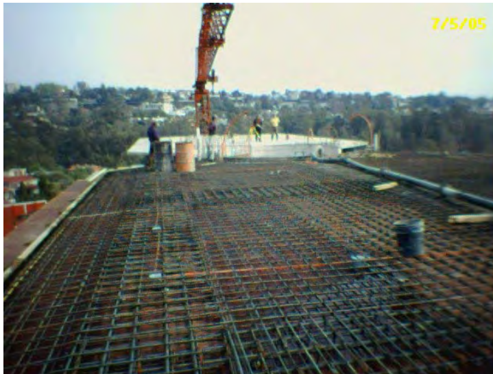
Fig. 58 Armado de doble parrilla en losa tapa de sky garden.
