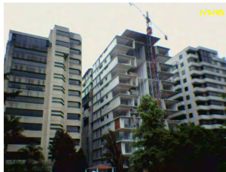
Fig.37 Altura de torre grúa con respecto al edificio.
