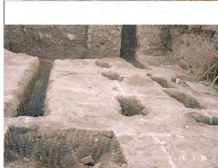
Fig. 15 Excavación mecánica de cepas.
