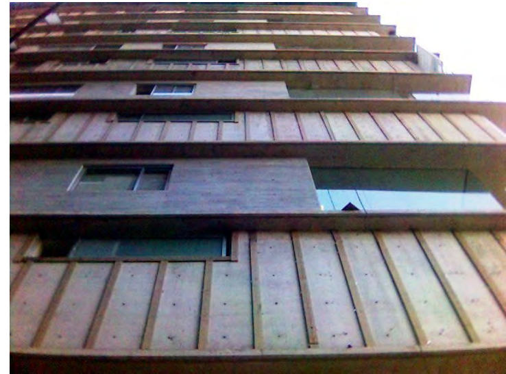
Fig. 112 Bastidor colocado en fachada nororiente.
