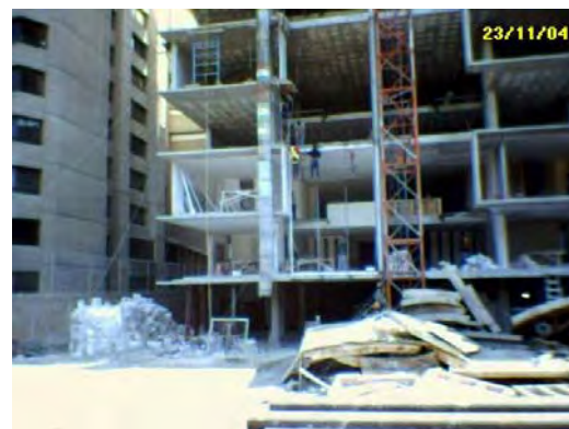
Fig. 87 Inicio de yeso en muros y plafon.
