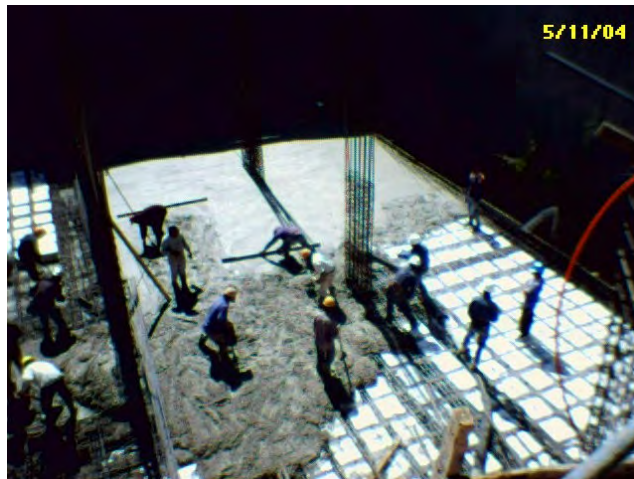
Fig. 55 Armado de nervaduras en losas.
