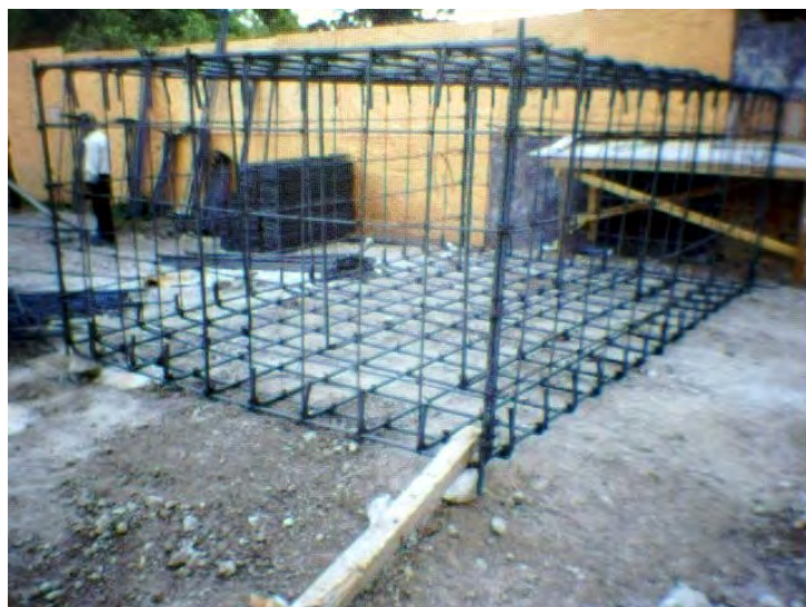
Fig. 24 Armado de dado de torre grúa.
