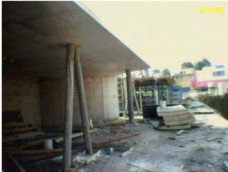
Fig. 59 Columnas metálicas en PH.
