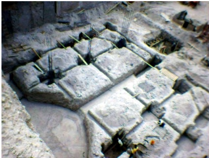
Fig. 19 Cimentación N-28.30 vista desde N-12.40.
