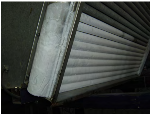
Fig. 3.8.1.3 Imagen del hielo en el evaporador durante la estabilización del sistema
