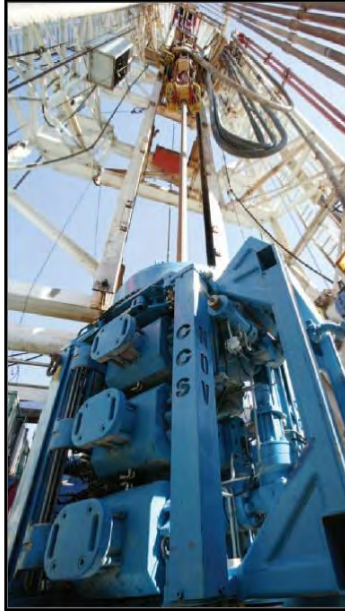
Figura 2.16 La unidad principal del Sistema de Circulación Continua está localizada sobre el piso de plataforma sobre la mesa rotaria. El CCS permite que la tubería de perforación sea añadida o removida de la sarta de perforación cuando se perfora o se hacen viajes sin interrumpir la circulación del pozo.
