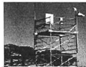
MONTAJE EN PLATAFORMA ALTA
