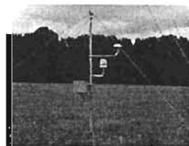
MONTAJE EN MÁSTIL
