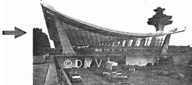
Cables en forma paralela
