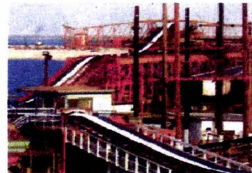
18.- Flujo de sal por bandas transportadoras, al muelle de carga de barcasas, (ESSA).
