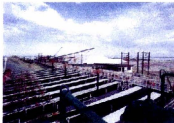
17.- Vista de la planta de lavado y del área de apilamiento, (ESSA).
