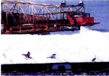
19.- Carga de barcasas con capacidad de 10,000 toneladas métricas, (ESSA).
