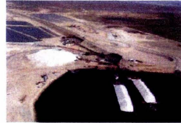
21.- Vista del área de carga de barcasas y de la planta de lavado, (ESSA).
