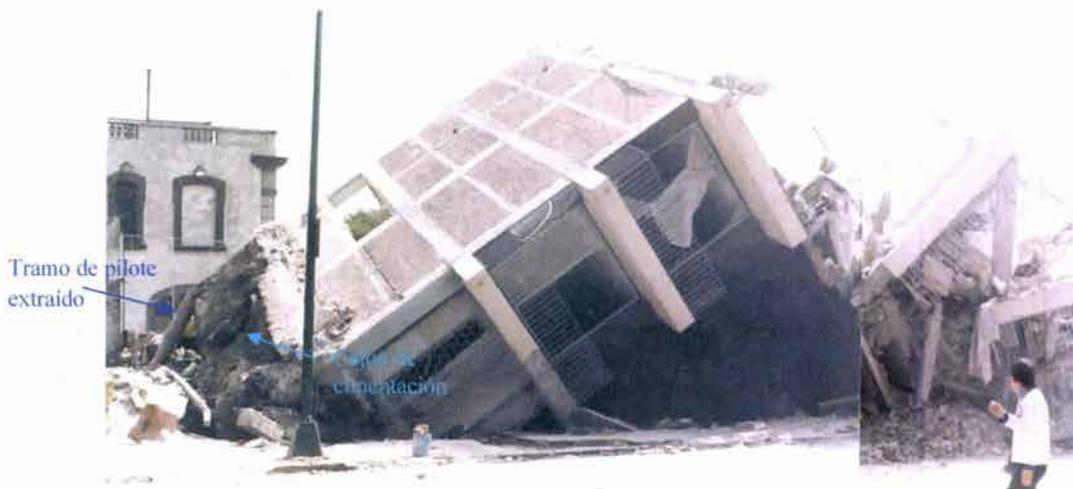
**Fig. 1.2** Colapso total por volteo de un edificio cimentado con cajón y pilotes de fricción (190985)
