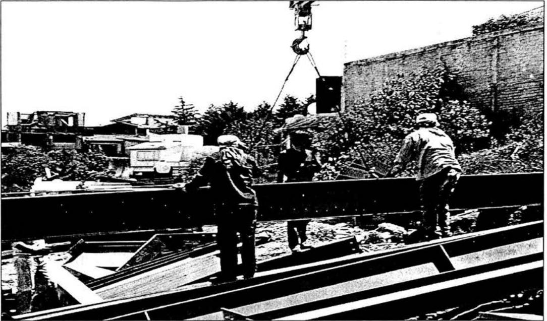
Figura No. 12 Maniobra de descarga de ensambles en obra.
