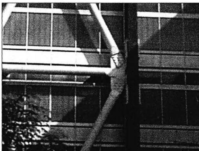
Figura No 33. Contravientos de fricción.
