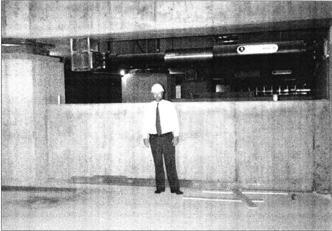
Figura No 57. Amortiguador, instalado junto con aisladores sísmicos.
