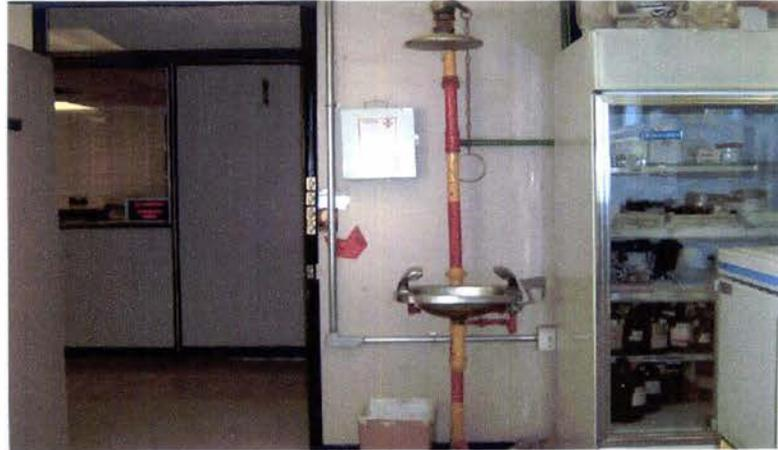
El laboratorio cuenta con un sistema de regadera de emergencia denominado labajos, su instalación es debido al uso de sustancias gaseosas-volátiles; este sistema requiere de una charola y cespól con una pendiente adecuada para el desalojo aprox. De .90 m x .90m , de área total.
