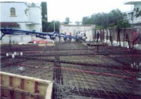
Foto 23.- Colado de losa tapa de estacionamiento
