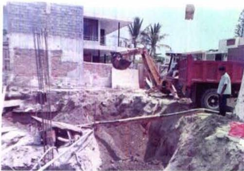
Foto 5.- Excavación con retroexcavadora
