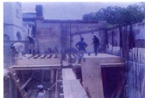
Foto 16.- Cimbra de columnas y losa tapa
