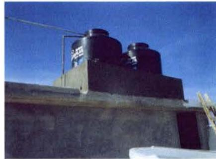
Abastecimiento de agua de sótano a tinacos en azotea mediante hidroneumático
