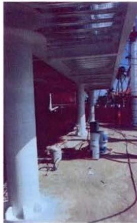
Foto 32.- Losacero en estructura
