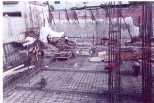
Foto 12.- Armado de losa de cimentación
