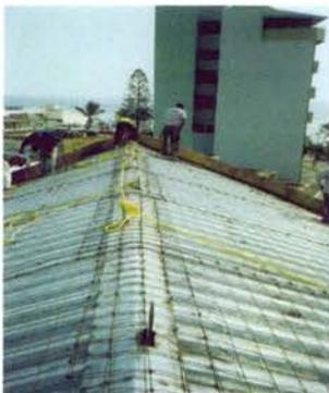
Foto 52.- Colocación de malla electrosoldada en cubierta
