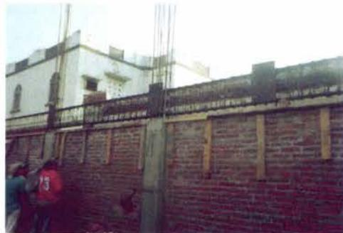
Foto 28.- Embebidos en trabe perimetral para llegada de vigas IPR
