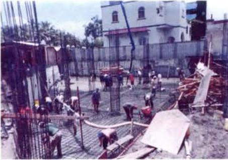
Foto 13.- Colado de losa de cimentación
