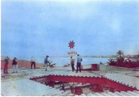
Foto 45.- Colocación de losacero y malla electrosoldada
