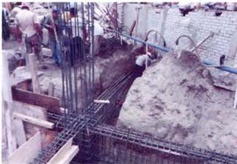
Foto 9.- Armado de traves de cimentación
