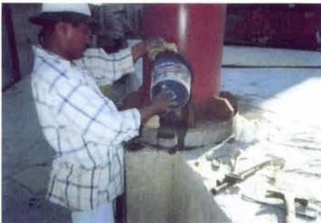
Foto 27.- Aplicación de estabilizador "grout"
