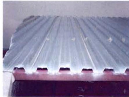
Foto 50 y 51.- Colocación de losacero en losa a 2 aguas sobre armaduras
