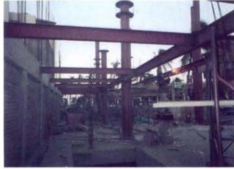
Foto 30.- Estructura mediante IPR 8" y 10"
