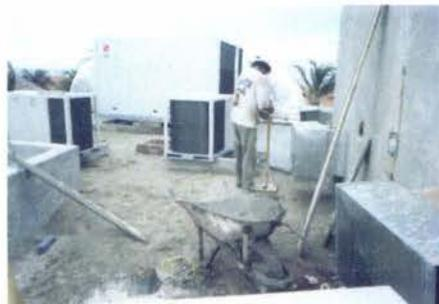
Relleno con tepezil en losa plana
