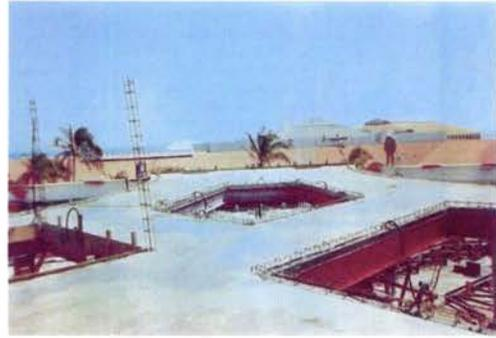
Foto 46.- Colado de losa plana en cubierta
