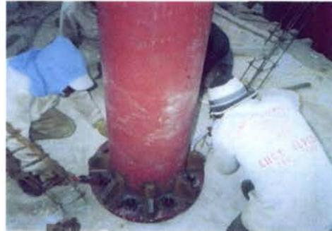
Foto 25 y 26.- Nivelación de columnas mediante nivel topográfico y tuercas niveladoras
