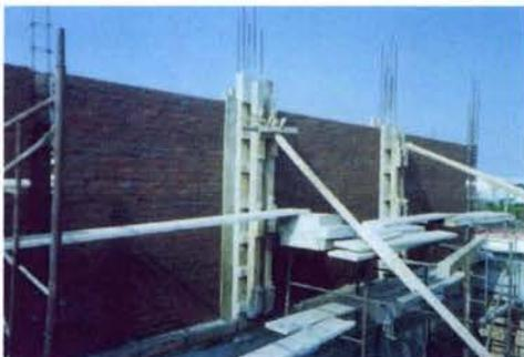
Foto 41.- Hechura muro de tabique y colado de columnas
