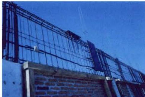
Foto 42.- Armado de trabe y colocación de embebidos
