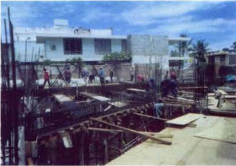
Foto 19.- Cimbra de losa tapa de estacionamiento
