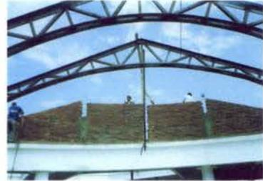
Foto 47, 48 y 49.- Fabricación y colocación de armaduras en planta de cubierta
