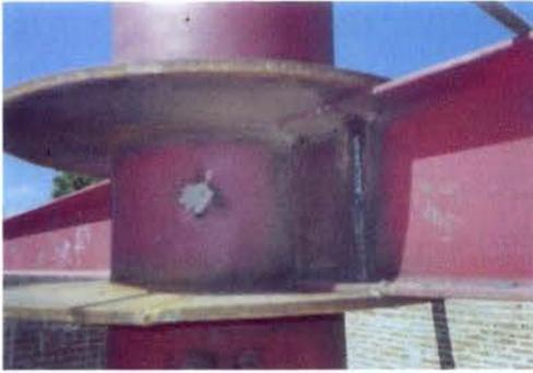
Foto 29.- Conexión de vigas IPR y columna metálica
