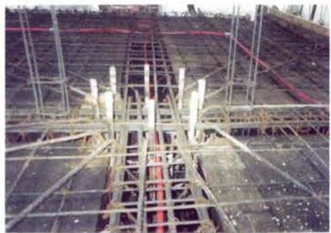
Foto 22.- Anclas para montaje de estructura
