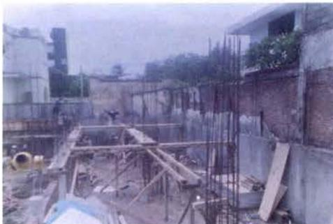
Foto 15.- Cimbra de columnas y losa tapa
