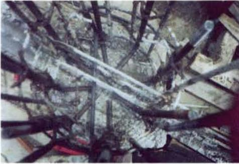
Foto 17.- Colocación de anclas en armado de columna
