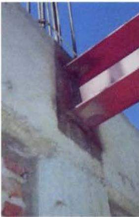
Foto 31.- Llegada de viga IPR a trabe de concreto
