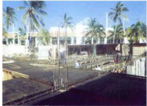
Foto 20.- Cimbra de losa tapa de estacionamiento
