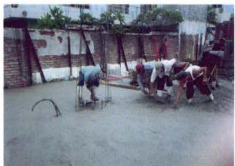
Foto 24.- Colado de losa tapa de estacionamiento
