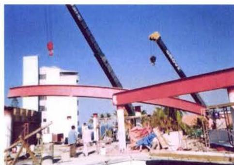
Foto 43 y 44.- Colocación de vigas fabricadas en planta de cubierta
