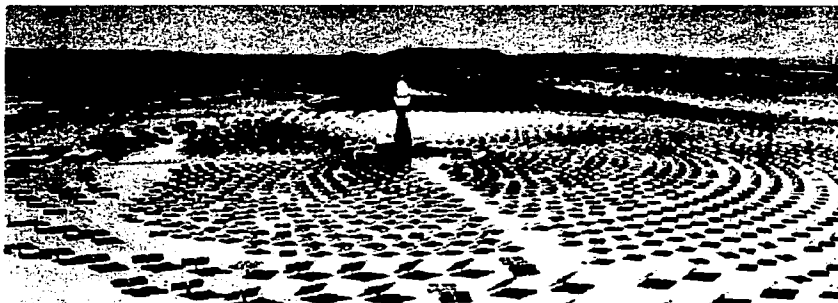
Figura 6 - 3. Planta eléctrica de 10 MW. Solar One, situada en Barstow California
