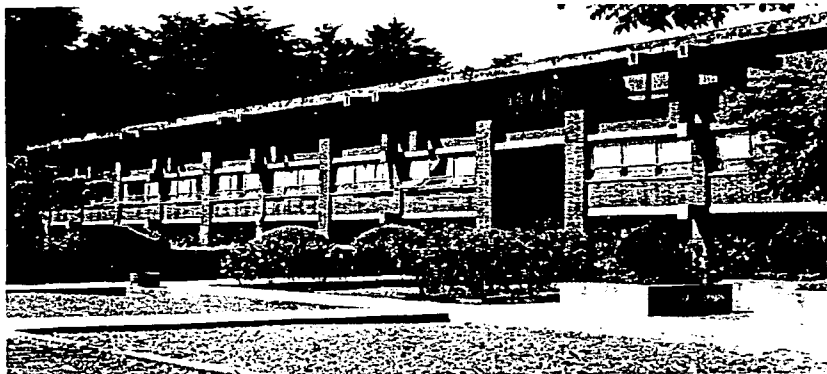
Vista lateral del edificio 1.
