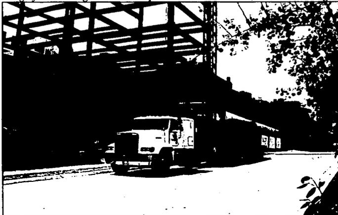
Los elementos desde planta deben cargarse en la plataforma del trailer de tal forma que al momento de su descarga en obra sea según convenga al proceso del montaje de la estructura metálica, esto es:
