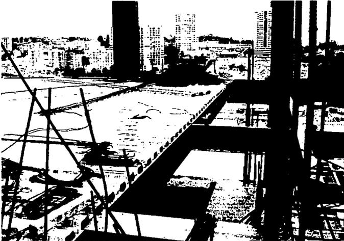
El constructor de obra civil será el encargado de hacer los siguientes procesos de construcción para hacer le sistema de losacero y la sección compuesta, estos procesos siguientes son: la instalación de la malla electrosoldada, el apuntalamiento temporal (si es necesario), fronteras de losa, colado de losa y acabado.
