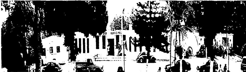
Figura 7 Fachada principal de la biblioteca. Palacio Municipal.
