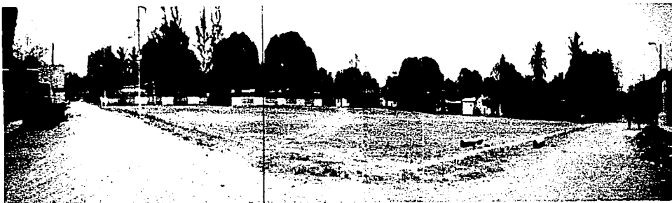
Figura 21 Vista de la fachada suroeste del terreno que se propone utilizar para el proyecto.
