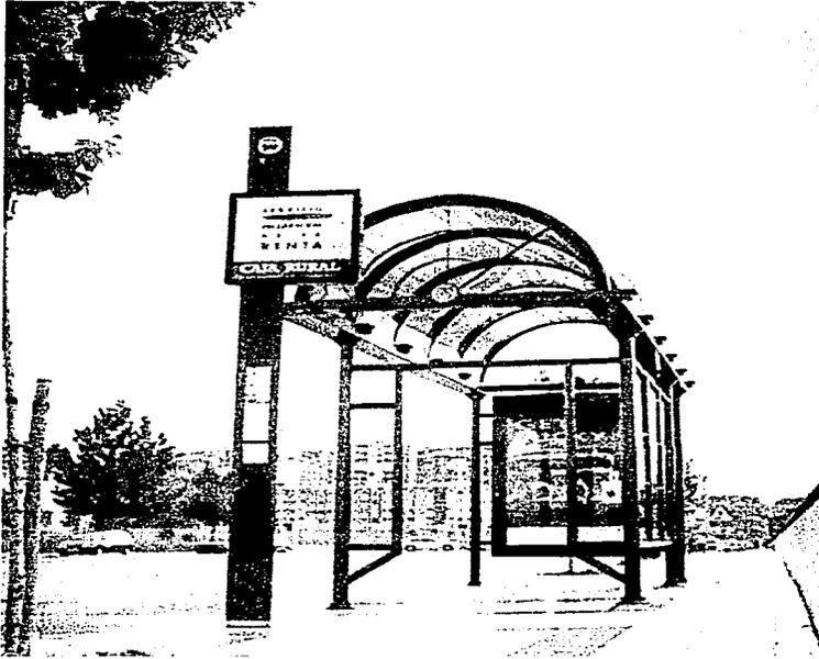
**ANÁLISIS.** La cubierta curva ayuda, pues tiene menor incidencia del sol. Los señalamientos propician un claro sistema de orientación y simplifica posibles confusiones.
