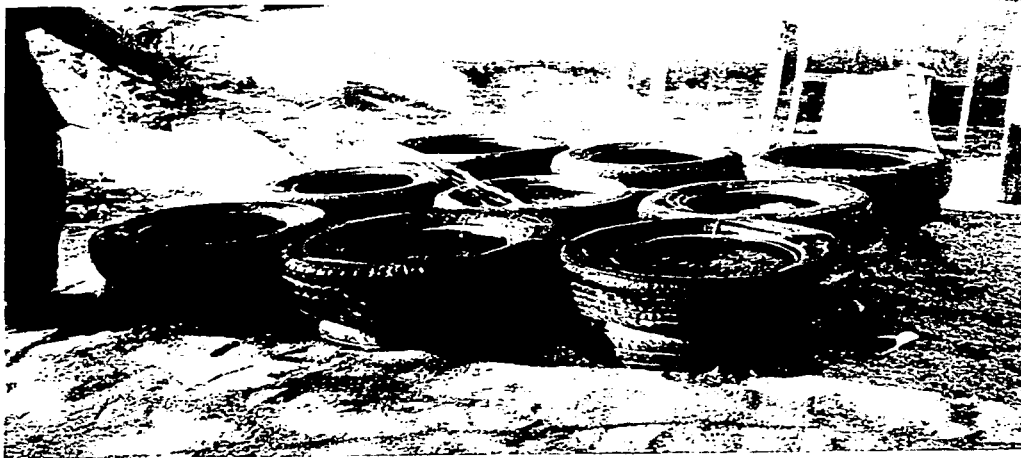
Figura 35. Neumáticos rellenos con tierra y apisonados.
