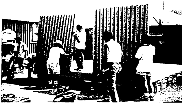
Figura 25. Montaje de la pared de cartón.
