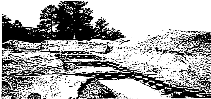
Figura 17. Cimientos con neumáticos.
