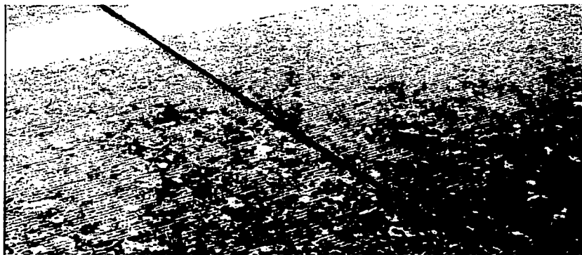
ESTA FOTO INDICA LA MISMA SUPERFICIE, PERO CON DESBASTE MEDIANTE DISCO DIAMANTADOS CUATRO MESES DESPUÉS.
