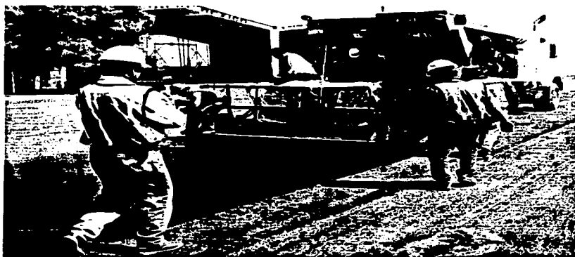
COLOCACION DE MORTERO ASFALTICO EN PLATAFORMAS
