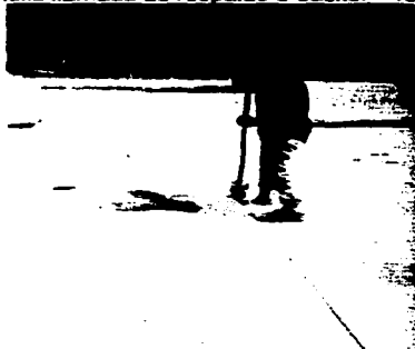
Insertión de la tira de respaldo de poli estireno, previo a la aplicación del sello
