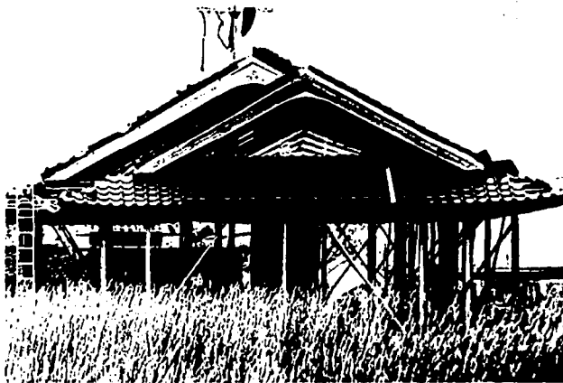
6.2 Casa japonesa en construcción
