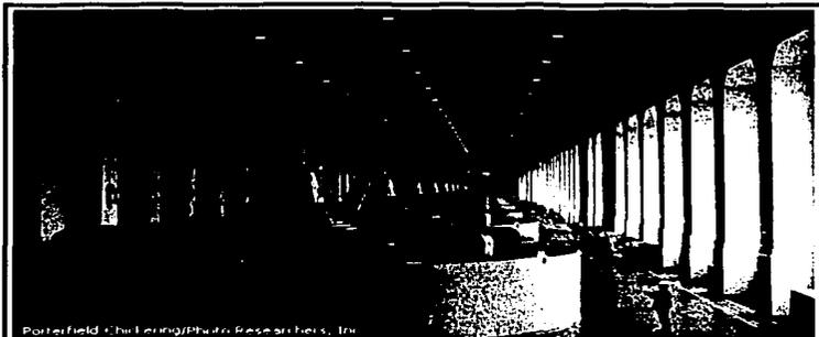
FIG. 4.1.1 GENERADORES DE LA PRESA BONNEVILLE, EN OREGÓN (ESTADOS UNIDOS) PRODUCEN ELECTRICIDAD MEDIANTE TURBINAS MOVIDAS POR AGUA. PORTERFIELD-CHICKERING/PH. INC.
