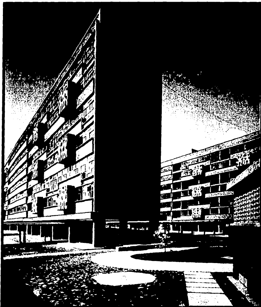
Conjunto habitacional Presidente Juárez, Mario Pani. Mientras que la solución estética de los edificios fue impecable, la respuesta a las necesidades interiores (como el área de tendido) se dejó a un lado. Estas fotografías corresponden al fin de la obra, antes de que la gente "arruinara" tan perfectos volúmenes con cortinas y ropa secándose en las ventanas.
