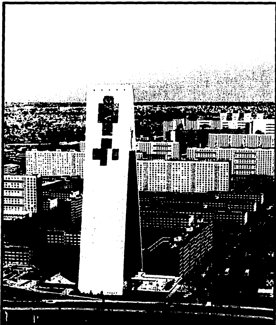
Centro Urbano Nonoalco - Tlatelolco (1964). Este conjunto, que alberga una población de cerca de cien mil habitantes, se construyó con el doble propósito de ofrecer vivienda a los trabajadores y de promover las bondades del gobierno en turno, cuatro años antes de que México se presentara ante el mundo como un país moderno.
