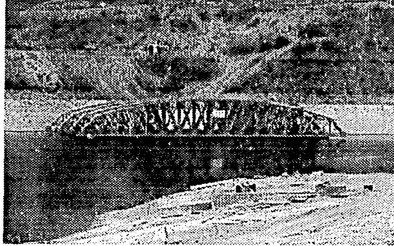
Figura 8.1 Armaduras de acero de paso inferior del puente vehicular
